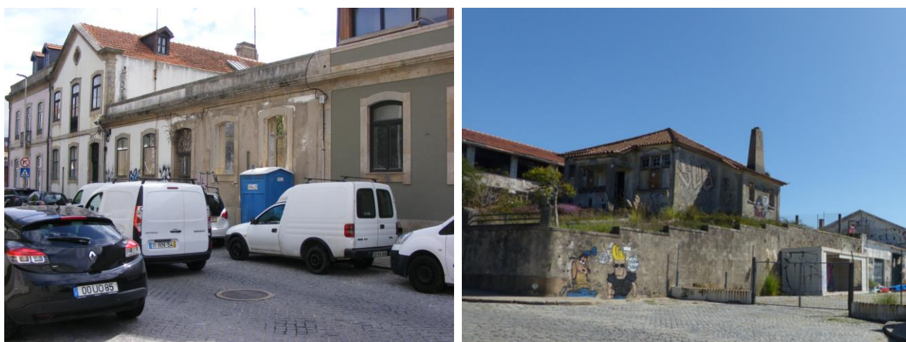
Figura 12 - Exemplo de edifícios em ruína localizados na Zona de Expansão Balnear, na Avenida Bento de Freitas e na Zona de Pedreiras, na Avenida Figueiredo Faria.
