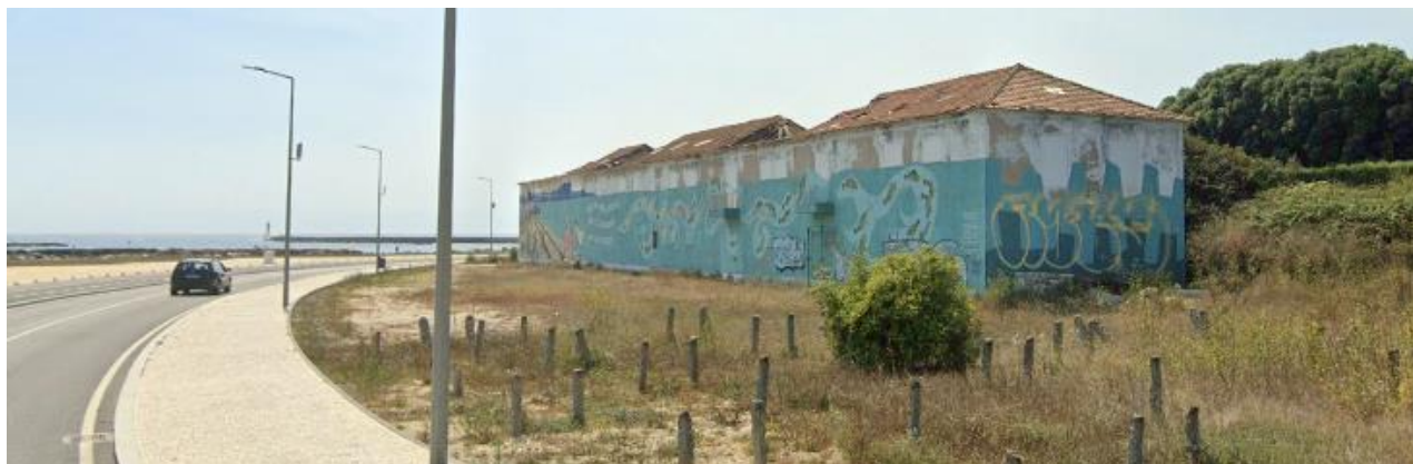
Figura 29 - Edifícios da Antiga Seca do Bacalhau. Fonte: Google Earth.
