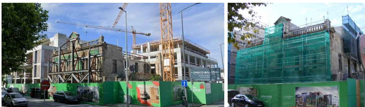
Figura 66 – Imóvel inventariado do século XX, em obras, na Avenida Júlio Graça.
