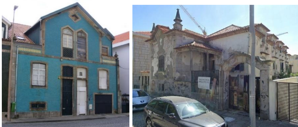
Residências unifamiliares do século XIX, em diferentes estados de conservação, na Avenida Bento de Freitas e na Avenida Júlio Graça.
