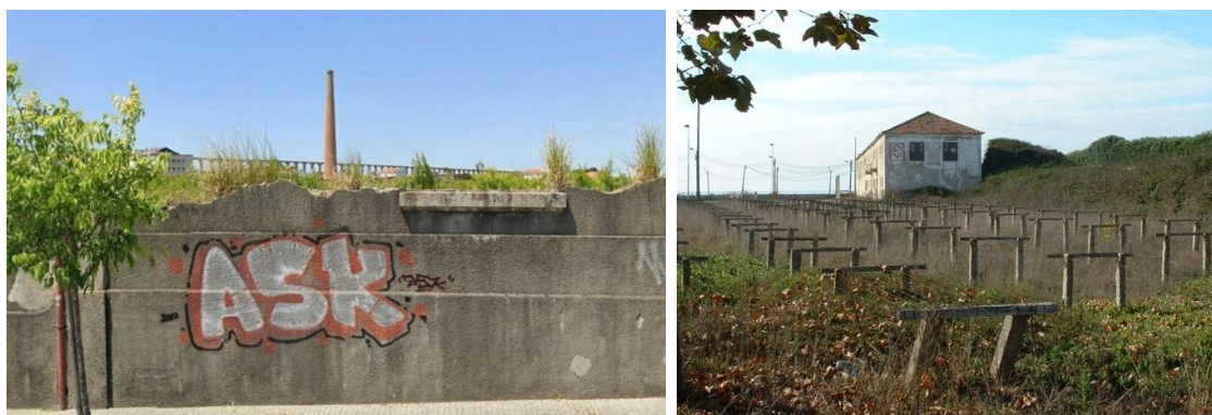
Figura 67 - Chaminé da antiga Fábrica Narfil e antiga Seca do Bacalhau. Fonte: Google Earth e portal online CMVC.
