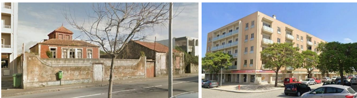
Figura 8 - Edifícios construídos em diferentes épocas na ARU da Antiga Fábrica da Maconde. Fonte: Google Earth.
