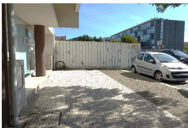
Figura 21 – Passeio interrompido dentro da ARU da Antiga Fábrica da Maconde.
