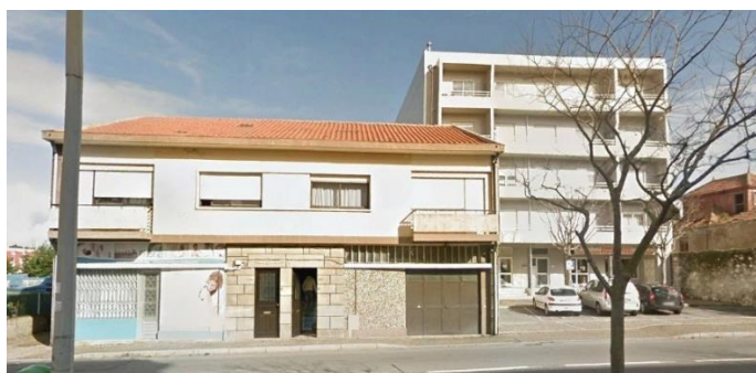
Figura 10 - Exemplo de tipologias encontradas na ARU da Antiga Fábrica da Maconde.
