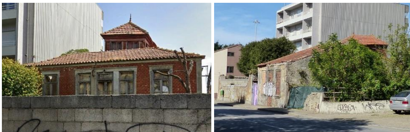
Figura 12 – Habitações unifamiliares com evidente estado de degradação na ARU da Antiga Fábrica da Maconde. Fonte: Google Earth e trabalho de campo (2023).
