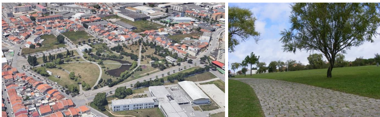
Figura 52 - Parque Urbano João Paulo II. Fonte: Trabalho de campo (2023) e Google Street View
