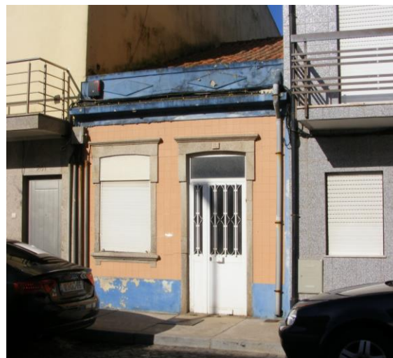
Rua da Alegria. Casa pintada com beiral embutido em laje
