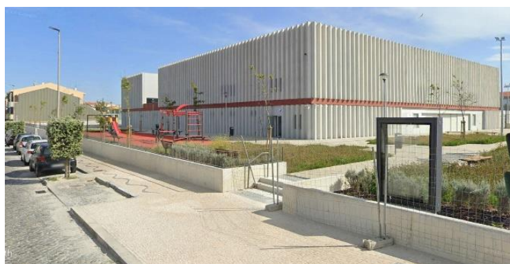
Figura 64 - Centro Comunitário de Caxinas, em construção.
