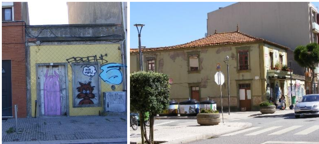
Figura 27 – Edifícios em mau estado de conservação, na Avenida Infante D. Henrique e na Avenida Dr. Carlos Pinto Ferreira, respetivamente.
