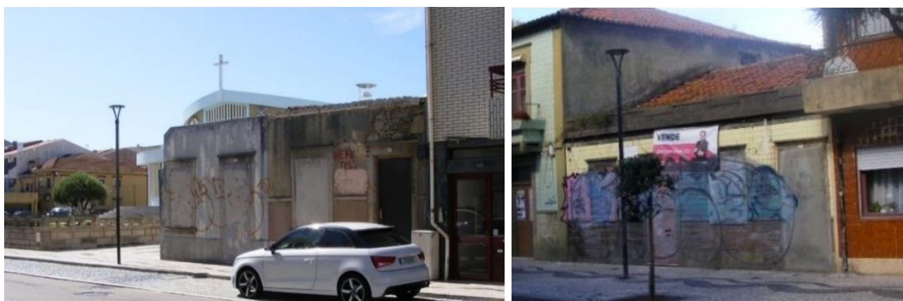
Figura 18 - Exemplo de edifícios em péssimo estado e em mau estado de conservação localizados na Avenida Dr. Carlos Pinto Ferreira.
