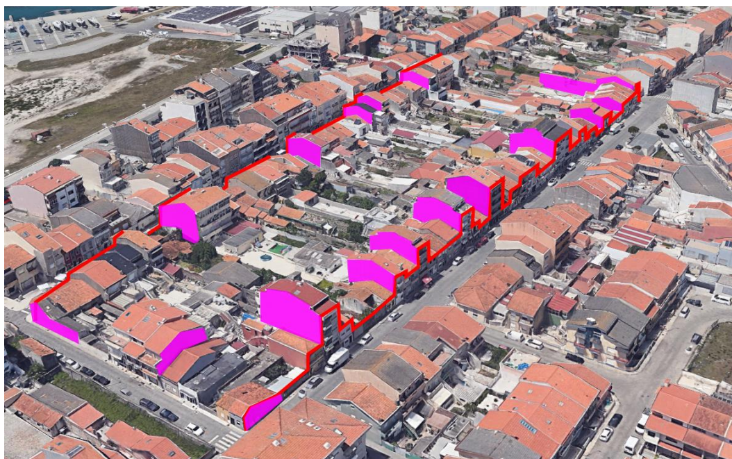
Figura 13 – Representação da falta de homogeneidade da cércea e das empenas cegas. Fonte: Elaboração própria sobre Google Earth.
