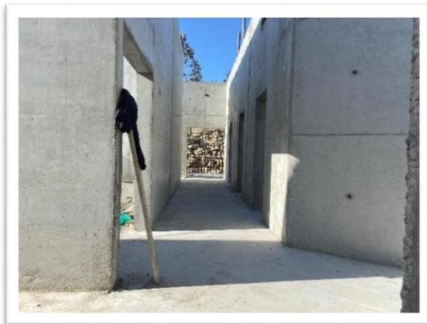
A construção do Centro de Receção da Cidade de Bagunte encontra-se numa fase adiantada de construção. O núcleo central do edifício encontra-se betonado, bem como a parede que define o corredor que faz a distribuição dos visitantes pelas diversas salas. Iniciou-se a construção das paredes exteriores do edifício. A obra é apoiada por verbas do FEDER, tendo sido adjudicado por um total de 448.095,00 €. Está a ser feita o acompanhamento arqueológico diário da obra.
