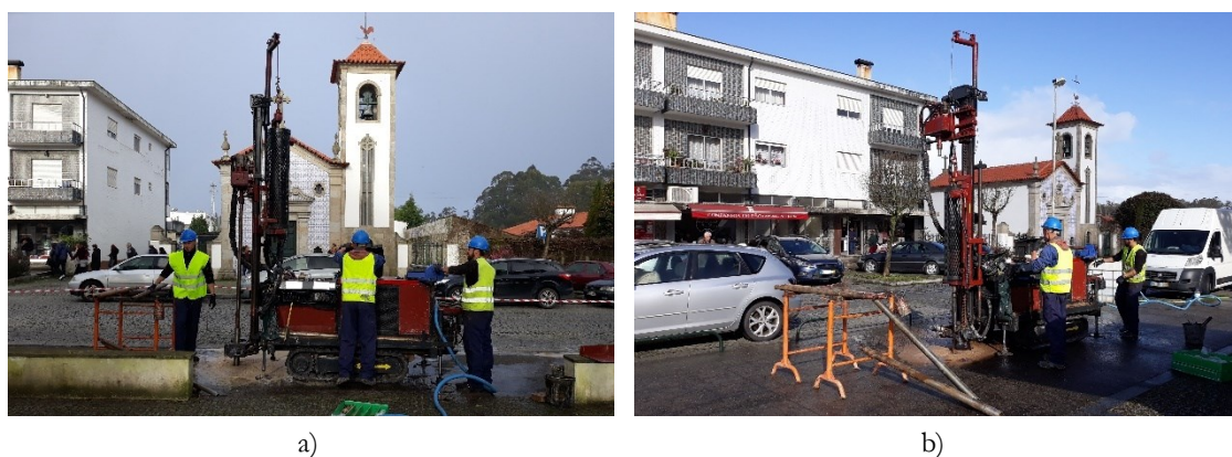
Figura 4 – Execução dos furos de sondagem: a) S1; b) S2/Pz.
