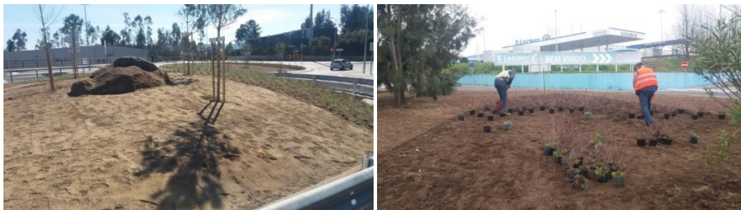
Figura 6.1-21 - Imagens relativas à execução de plantações de árvores e arbustos
