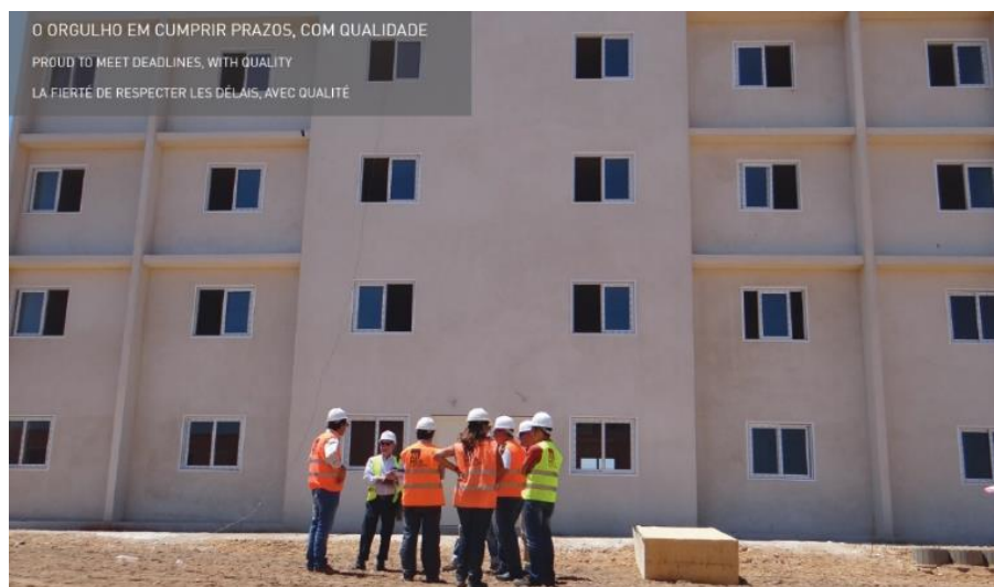
Figura 7.1-3 – Conjunto de edifícios para habitação social construídos pela MCA
