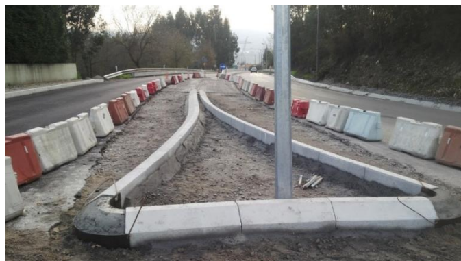
Figura 6.1-15 - Imagens relativas ao assentamento de lancis sobre lintel de betão
