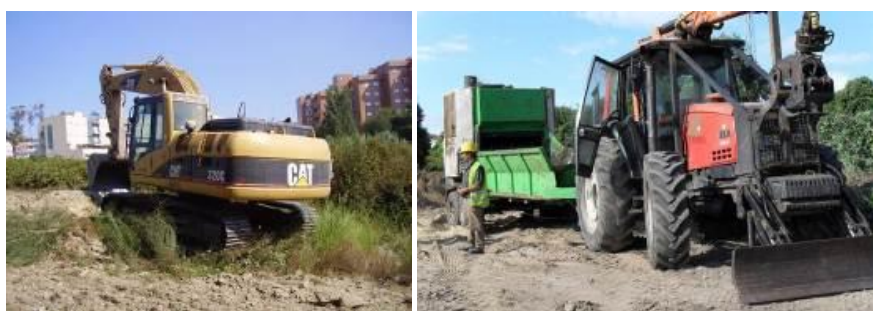
Figura 6.1-2 - Imagens de equipamento desmatagem/limpeza e trituração de vegetação
