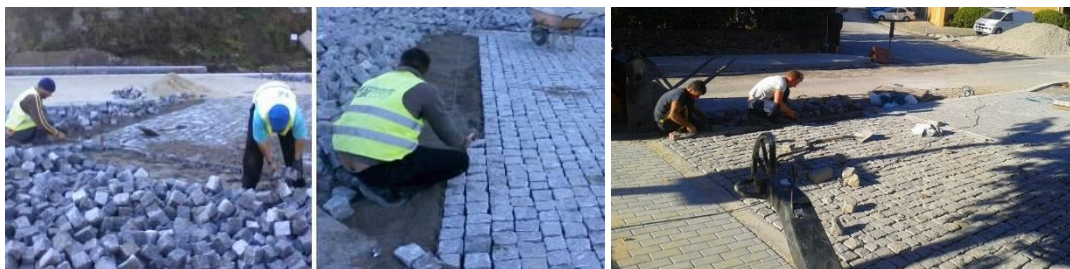
Figura 6.1-17 – Imagens relativas à aplicação de cubo de granito
