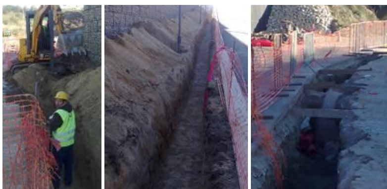
Figura 6.1-34 - Abertura de valas com altura reduzida para redes elétricas e de abastecimento
