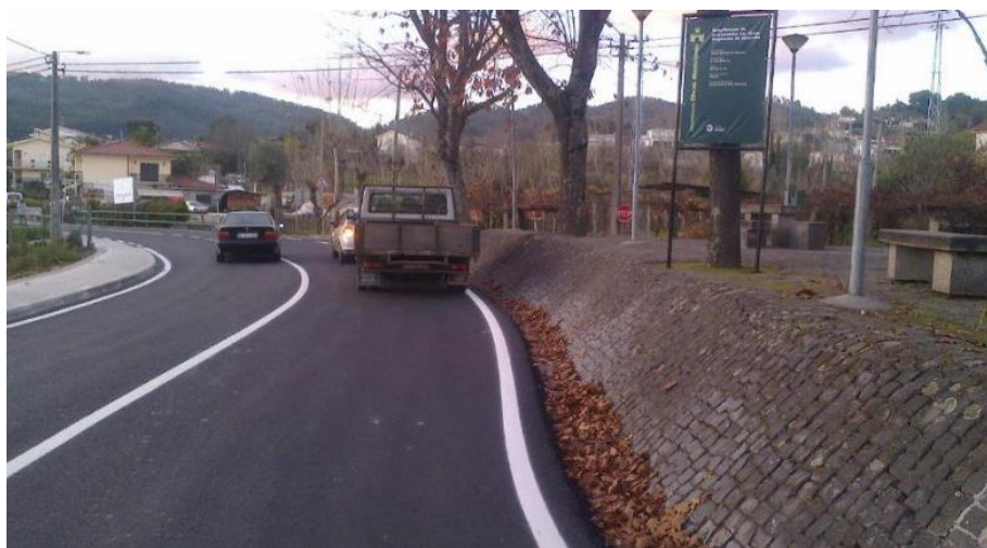
Figura 7.4-3 – Obras realizadas: Beneficiação de arruamentos em várias freguesias do concelho
