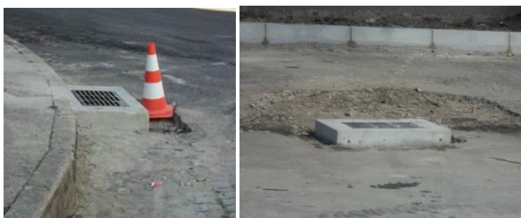
Figura 6.1-39 - Imagens relativas à execução de sumidouros
