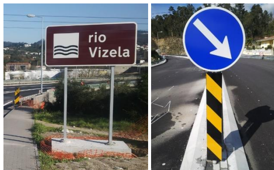
Figura 6.1-23 - Imagens relativas à instalação de sinalização vertical
