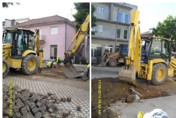
Figura 6.1-6 - Imagens relativas ao levantamento de pavimentos em cubo
