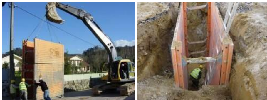
Figura 6.1-33 - Imagens relativas à entivação correntemente utilizada na execução de valas
