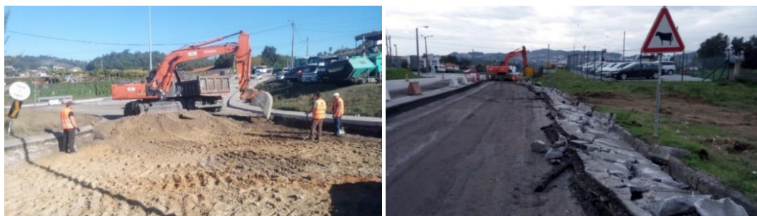
Figura 6.1-5 – Imagens relativas a trabalhos de demolição de pavimentos rodoviários
