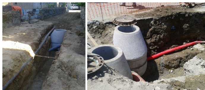
Figura 6.1-38 - Execução de caixas de visita em elementos pré-fabricados
