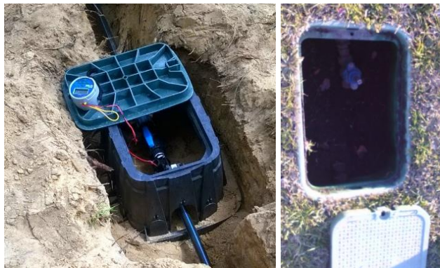
Figura 6.1-45 - Imagens da instalação de caixa e válvulas de rega
