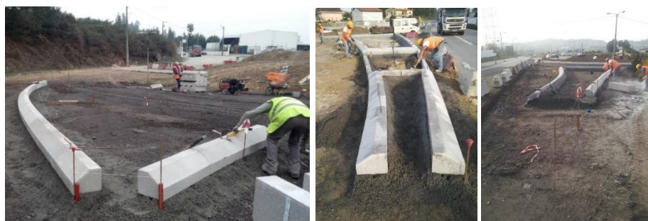
Figura 6.1-14 – Imagens relativas ao assentamento de lancis sobre lintel de betão
