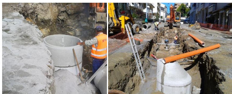
Figura 6.1-37- Execução de caixas de visita em elementos pré-fabricados
