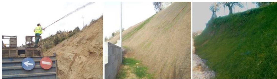
Figura 6.1-22 - Imagens referentes à aplicação de hidrossementeira/germinação
