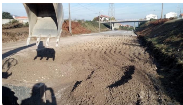
Figura 6.1-7 – Imagens relativas a trabalhos de demolição de pavimentos
