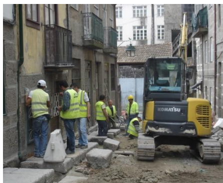
Figura 6.1-4 – Imagens relativas a trabalhos de remoção de guias/lancis
