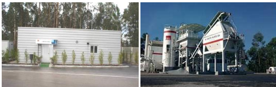
Figura 4.1-2 - Laboratório Central (à esquerda) e Central de Betuminosos (à direita)
