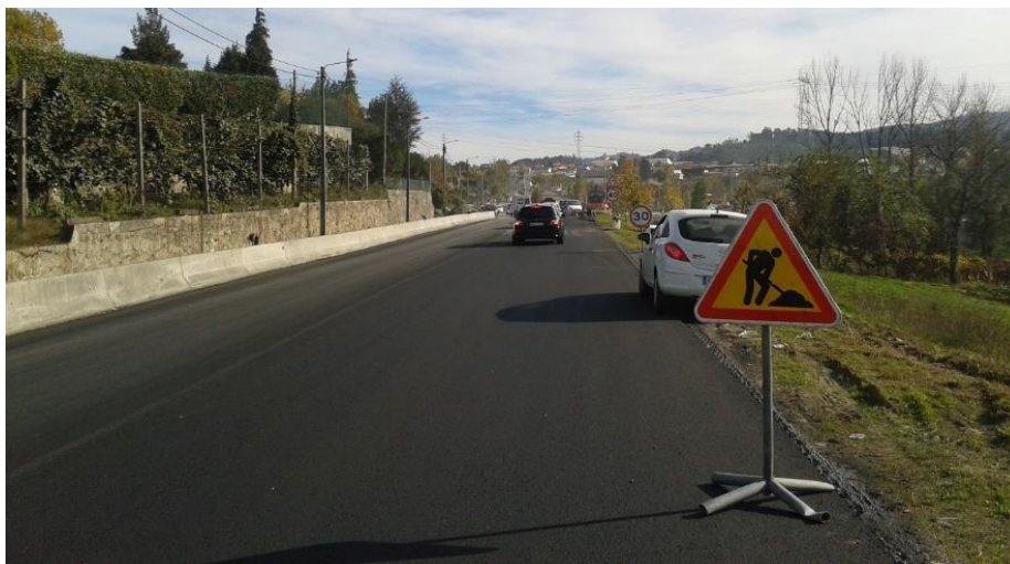
Figura 7.4-5 – Obras realizadas: Beneficiação do pavimento e sinalização da EN101 (durante a fase de execução)
