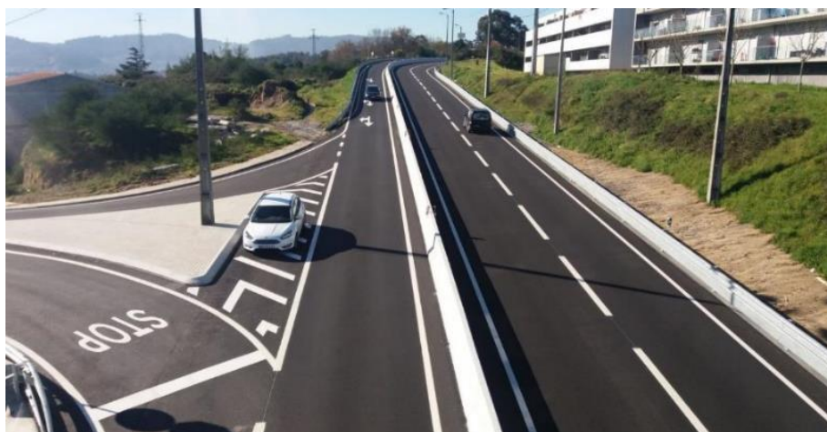
Figura 7.4-2 – Obras realizadas: Requalificação da Via Intermunicipal – VIM (5.950 km – 11.650 km)
