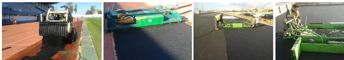
Figura 6.1-19 - Imagens relativas à execução de camada de base do pavimento sintético
