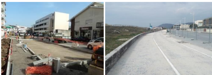
Figura 6.1-12 – Execução de camada de base em agregado britado
