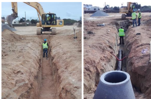
Figura 6.1-32 - Imagens relativas à abertura de valas para instalação de redes de infraestruturas
