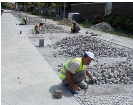
Figura 6.1-16 - Imagem relativa ao assentamento de microcubo
