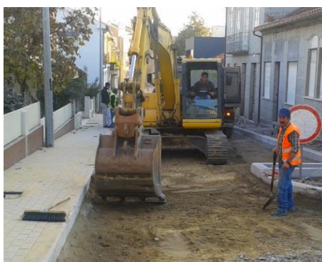
Figura 6.1-10 - Imagem relativa à abertura de caixa para pavimentação
