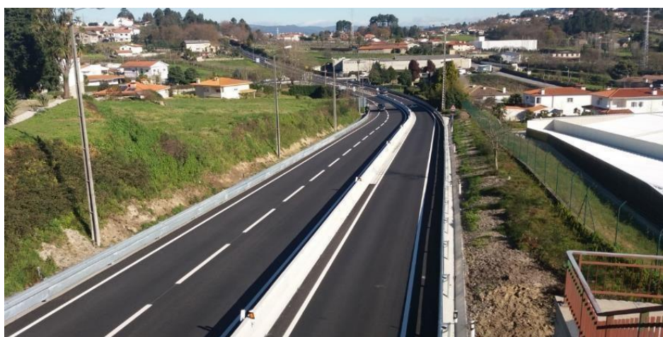
Figura 7.4-1 – Obras realizadas: Requalificação da Via Intermunicipal – VIM (5.950 km – 11.650 km)
