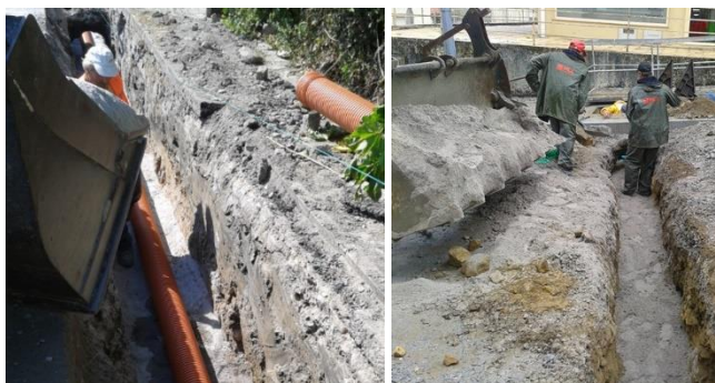
Figura 6.1-35 - Imagens tipo da aplicação de almofada de assentamento de tubagem
