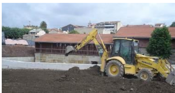
Figura 6.1-3 - Imagens tipo relativas à decapagem de solo vegetal
