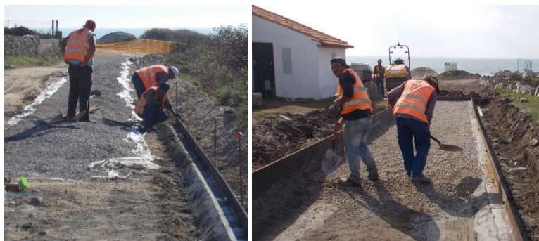
Figura 6.1-20 - Imagens relativas à aplicação de guia em aço
