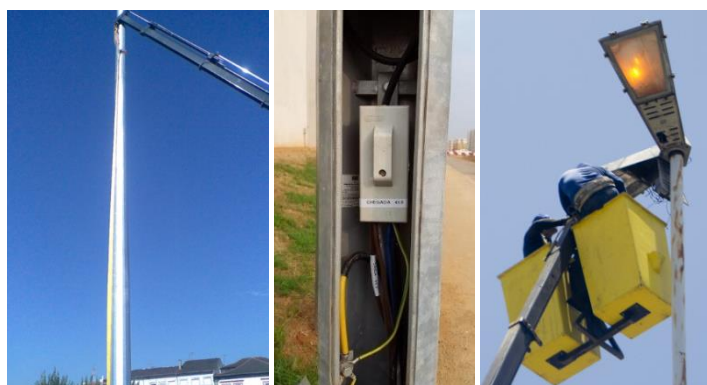
Figura 6.1-44 - Imagens tipo de montagem de colunas e luminárias
