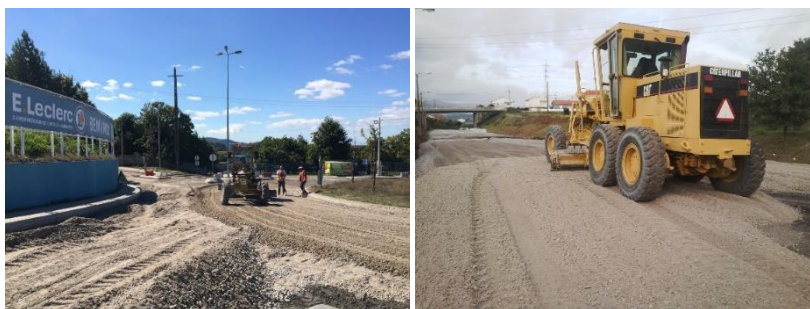
Figura 6.1-11 – Imagens relativas a trabalhos de espalhamento das camadas granulares
