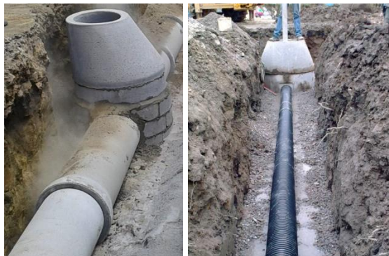
Figura 6.1-36 – Instalação de Tubagens nos dois tipos de redes (Betão – esq. e PP corrugado – dir.)
