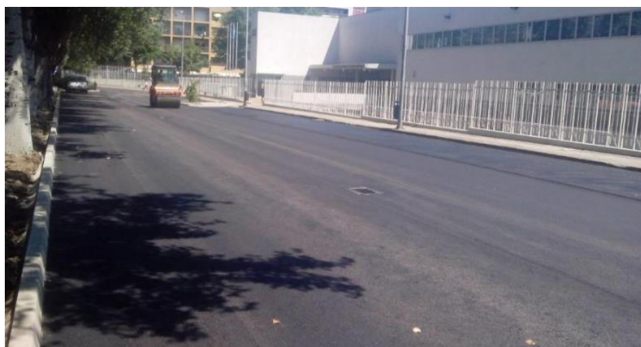
Figura 7.4-4 – Obras realizadas: Beneficiação de arruamentos em várias freguesias do concelho (fase de execução)
