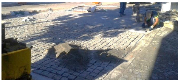
Figura 6.1-18 – Imagem relativa ao preenchimento de juntas do cubo de granito
