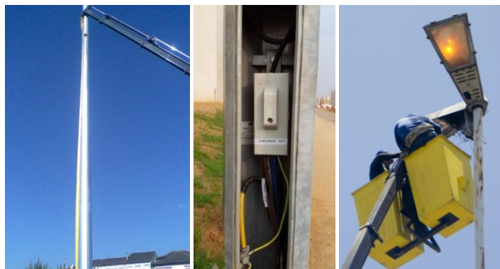
Figura 6.1-77 - Imagens tipo de montagem de colunas e luminárias
