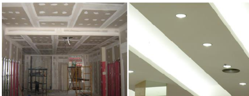
Figura 6.1-40 - Imagens de aplicação de placas em gesso, com características de revestimento
