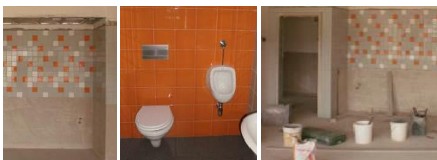
Figura 6.1-42 – Imagens de revestimento de paredes interiores em material cerâmico
