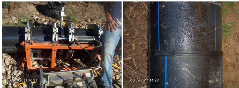
Figura 6.1-61 - Imagens de soldadura Topo a Topo
