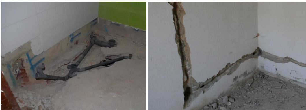
Figura 6.1-54 – Imagens referentes à abertura de roços para especialidades diversas
