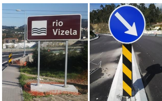
Figura 6.1-37 - Imagens relativas à instalação de sinalização vertical
