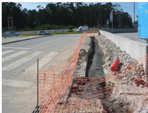
Figura 6.1-3 – Imagens relativas a trabalhos de remoção de passeios
