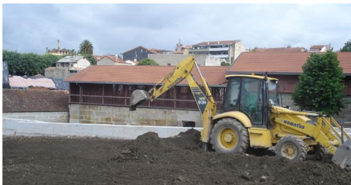
Figura 6.1-12 - Imagem relativa à decapagem de solo vegetal
