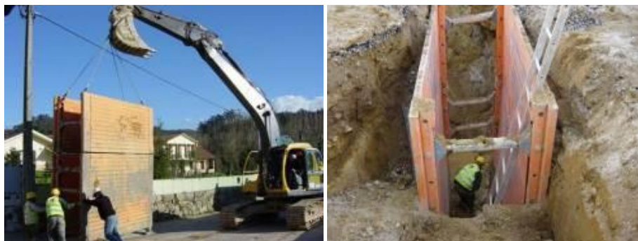
Figura 6.1-56 - Imagens relativas à entivação correntemente utilizada na execução de valas
