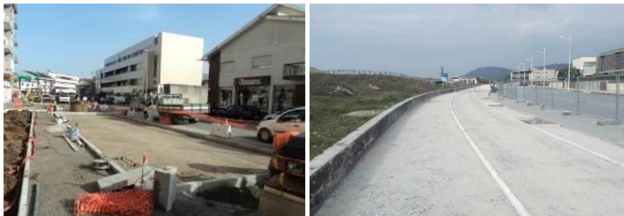
Figura 6.1-18 – Execução de camada de base em agregado britado
