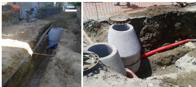
Figura 6.1-69 - Execução de caixas de visita em elementos pré-fabricados
