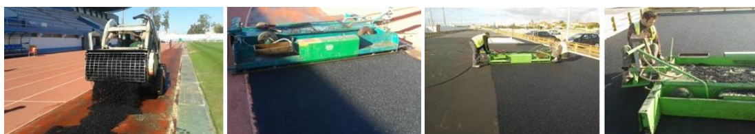
Figura 6.1-26 – Imagens relativas à execução de camada de base do pavimento sintético
