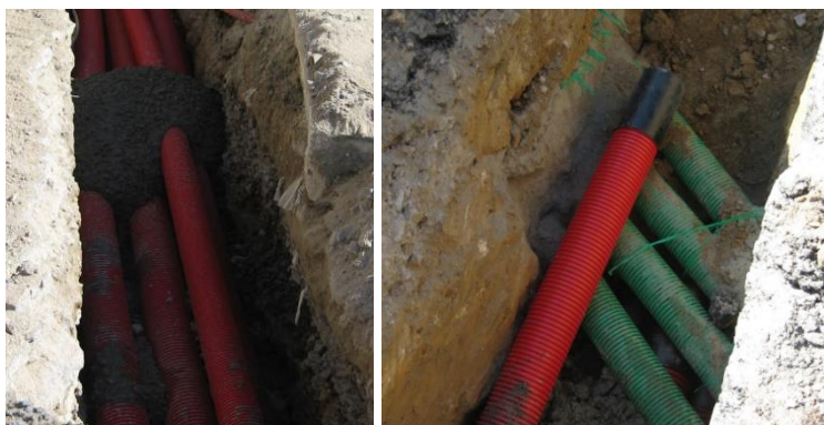
Figura 6.1-65 – Assentamento de tubagem em PEAD de infraestruturas elétricas e de telecomunicações
