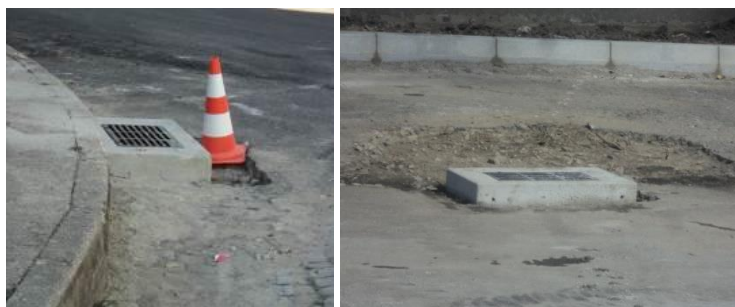
Figura 6.1-70 - Imagens relativas à execução de sumidouros
