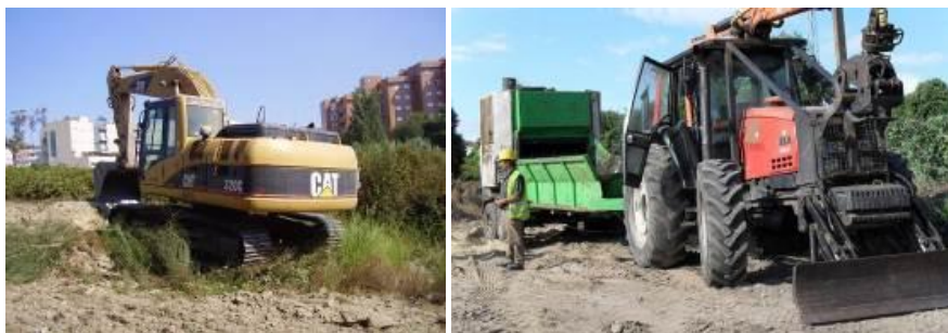
Figura 6.1-11 - Imagens de equipamento desmatção/limpeza e trituração de vegetação
