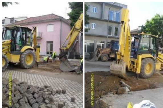
Figura 6.1-4 - Imagens relativas ao levantamento de pavimentos em cubo
