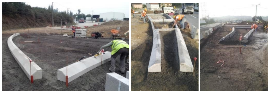
Figura 6.1-25 – Imagens relativas ao assentamento de lancis sobre lintel de betão
