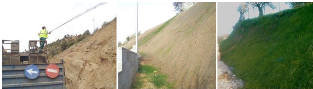
Figura 6.1-27 - Imagens referentes à aplicação de hidrossementeira
