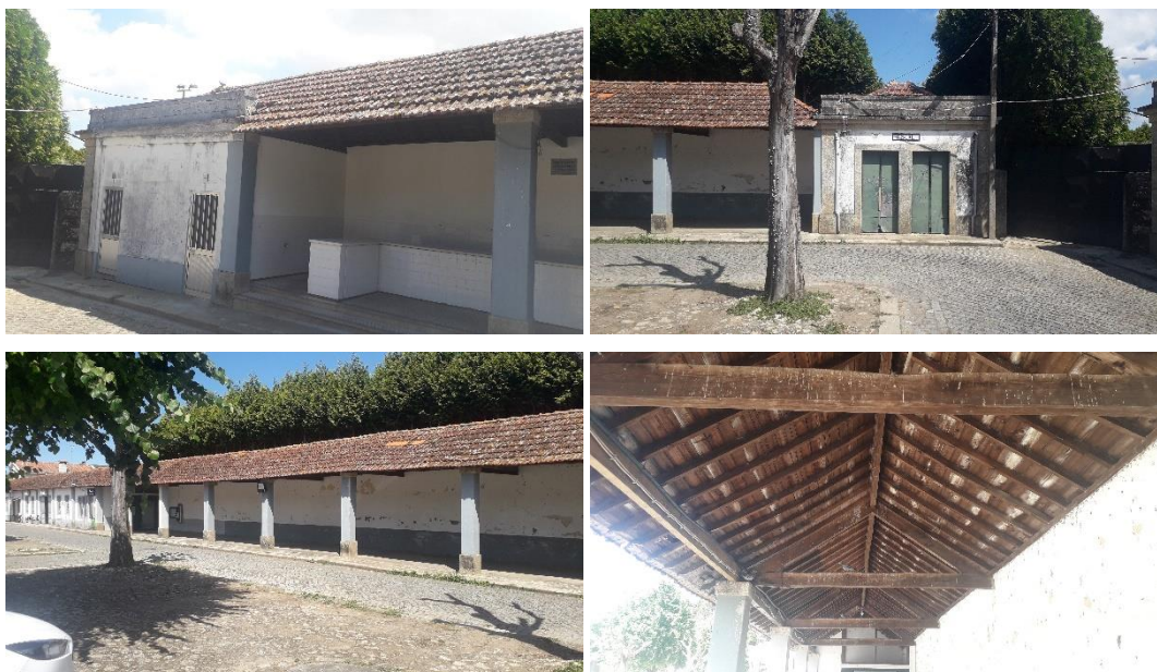
Figura 2.1-1 - Registo fotográfico da visita à obra: situação atual do edificado no Largo da Lameira
