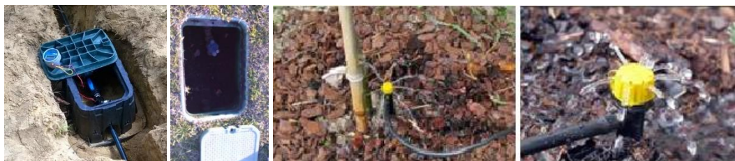
Figura 6.1-66 - Imagens da instalação de caixa e válvulas de rega e aspersores
