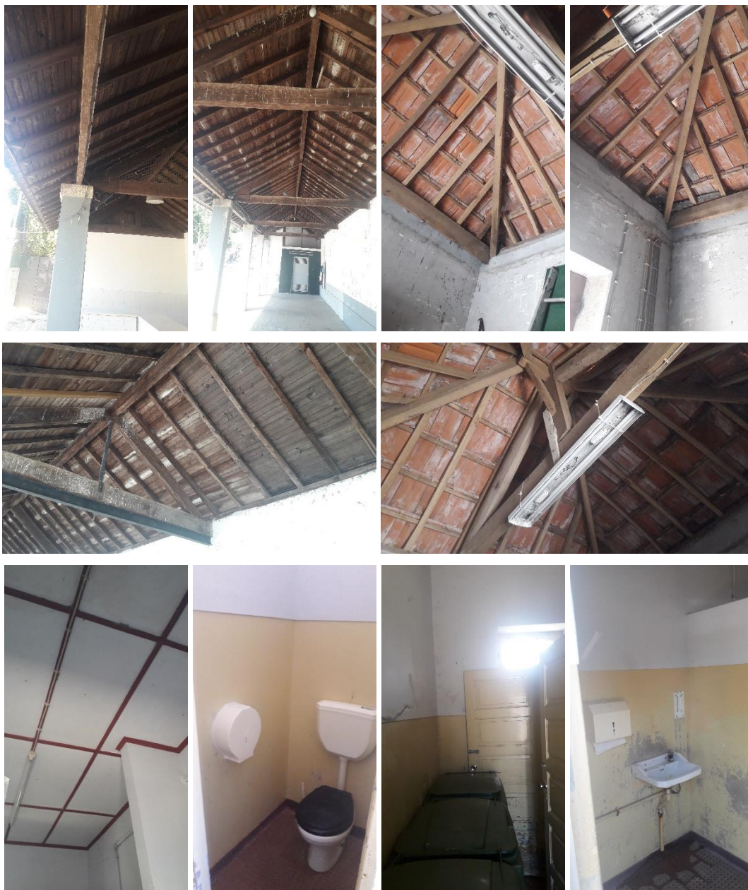
Figura 2.1-2 - Registo fotográfico da visita à obra: situação atual do edificado no Largo da Lameira
