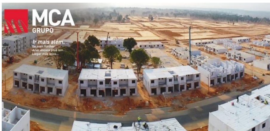
Figura 7.1-1 – Conjunto de edifícios para habitação social construídos pela MCA
