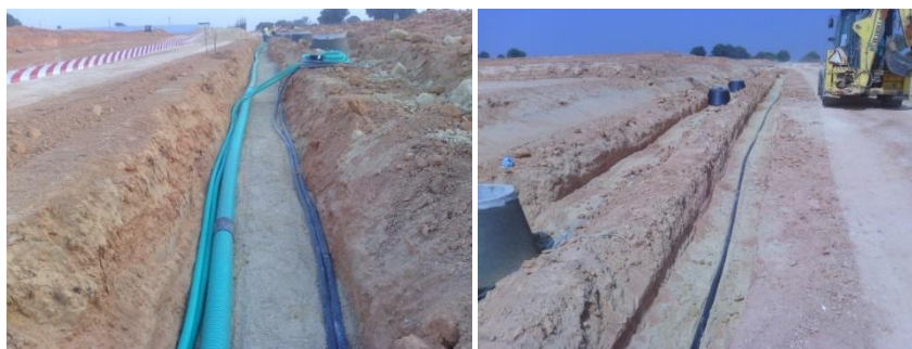
Figura 6.1-74 – Imagens referentes à instalação de cabos elétricos em vala ou tubo
