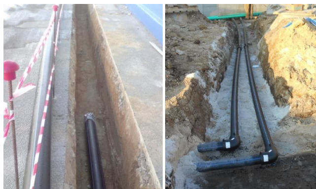
Figura 6.1-60 – Imagens da instalação de tubagem de PEAD em vala
