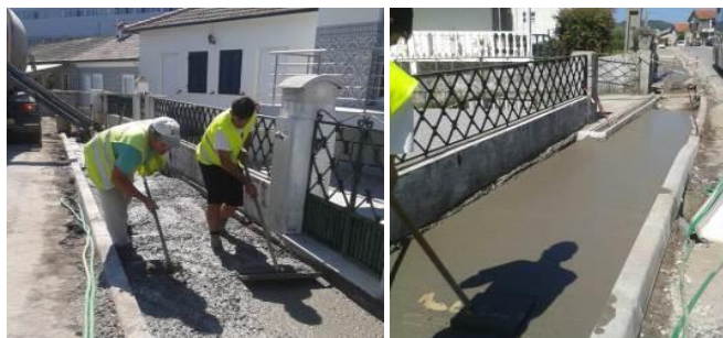
Figura 6.1-19 – Imagens relativas à execução de massame
