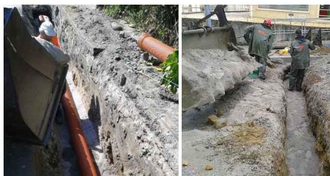
Figura 6.1-58 - Imagens tipo da aplicação de almofada de assentamento de tubagem
