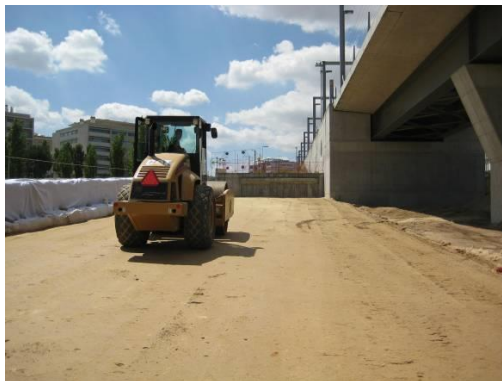
Figura 6.1-15 – Imagem relativa à compactação na execução de aterros
