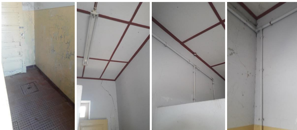
Figura 2.1-3 - Registo fotográfico da visita à obra: situação atual do edificado no Largo da Lameira
