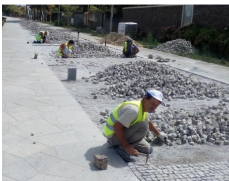
Figura 6.1-22 - Imagem relativa ao assentamento de microcubo
