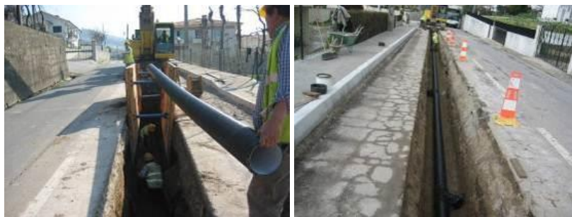
Figura 6.1-63 – Assentamento de tubagem em PVC
