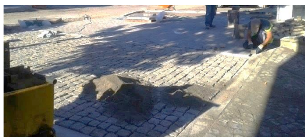
Figura 6.1-21 – Imagem relativa ao preenchimento de juntas do cubo de granito
