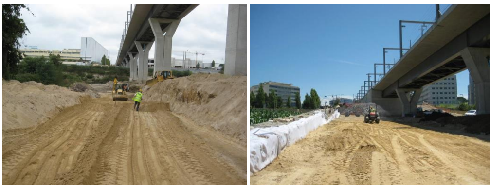
Figura 6.1-14 – Imagens relativas à execução de aterros e compactação das várias camadas
