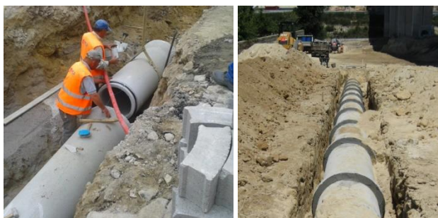
Figura 6.1-64 - Instalação de tubagens de betão vibrado
