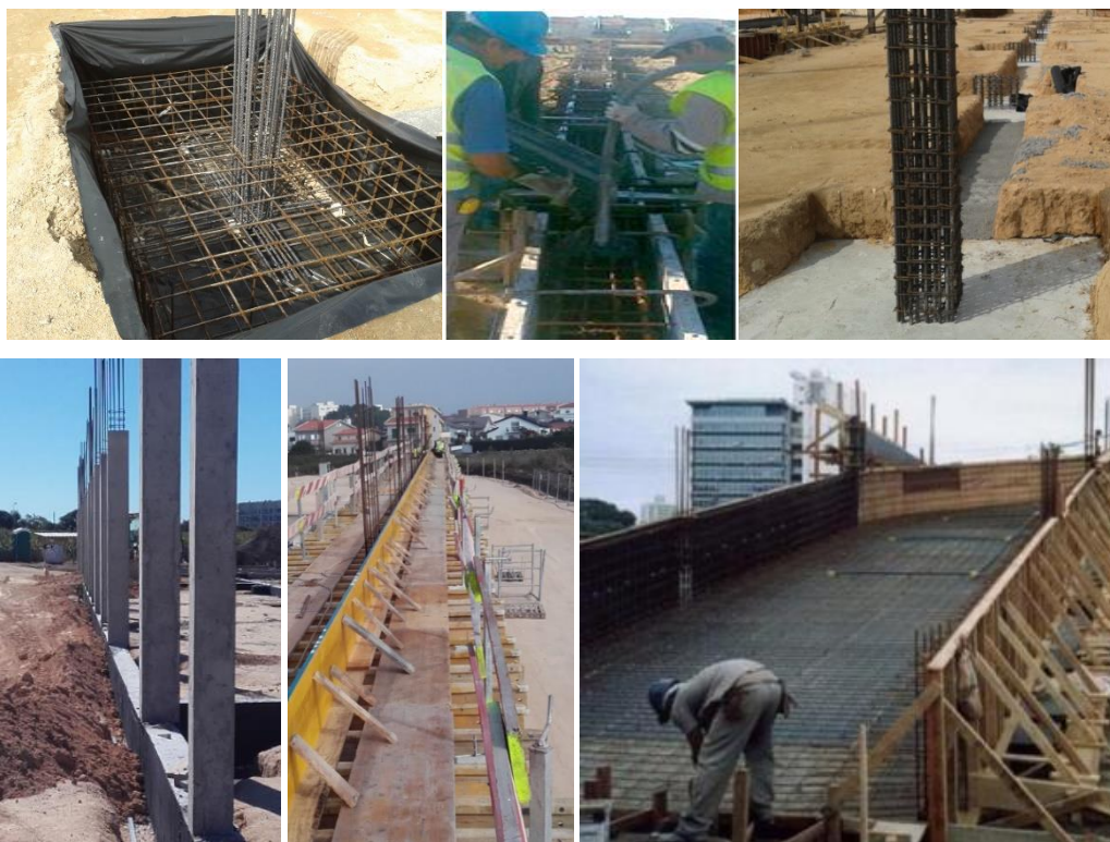
Figura 6.1-53 - Imagens exemplificativas relativas à execução de estruturas de betão armado
