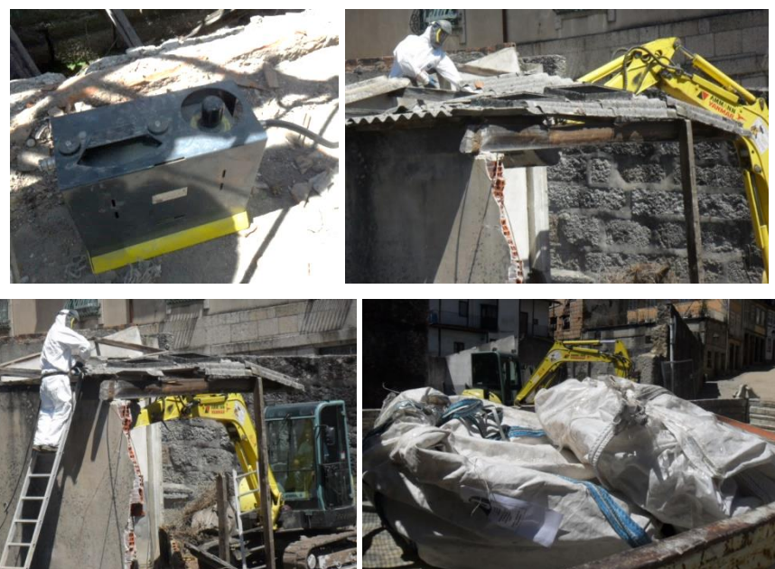
Figura 6.1-8 - Imagens relativas à recolha seletiva de telha de em fibrocimento
