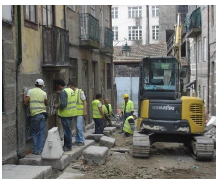
Figura 6.1-6 – Imagens relativas a trabalhos de remoção de guias/lancis
