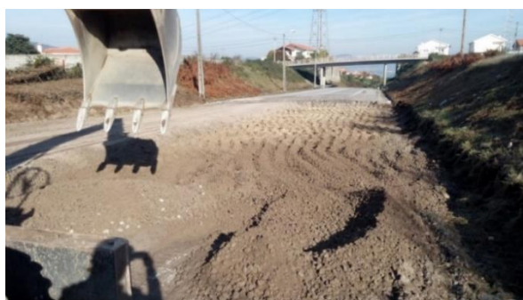
Figura 6.1-5 – Imagens relativas a trabalhos de demolição de pavimentos
