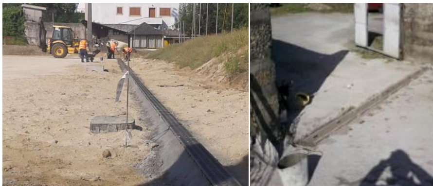
Figura 6.1-72 - Instalação de canal para recolha de águas pluviais
