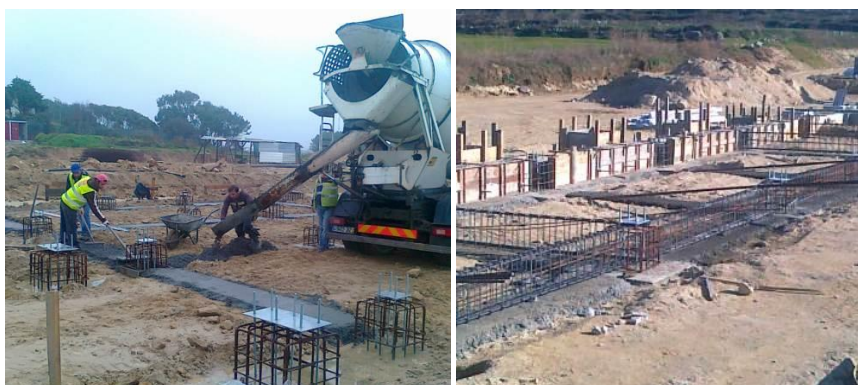
Figura 6.1-52 – Imagens relativas à aplicação de betão de limpeza, espalhamento e regularização
