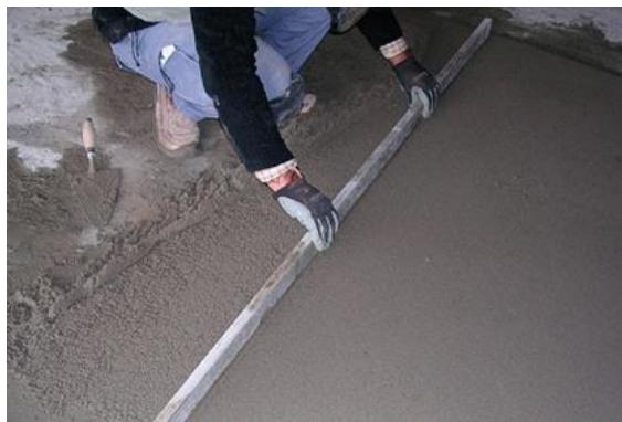
Figura 6.1-38 - Imagem representativa de execução de betonilhas
