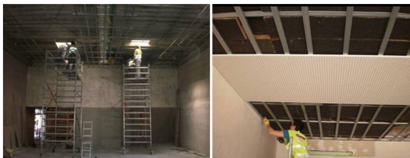
Figura 6.1-39 - Imagens referentes à aplicação em tetos do sistema de suporte em calhas
