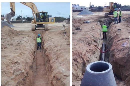
Figura 6.1-55 - Imagens relativas à abertura de valas para instalação de redes de infraestruturas
