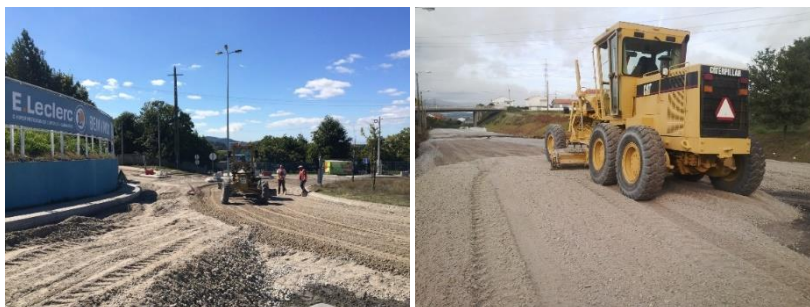
Figura 6.1-17 – Imagens relativas a trabalhos de espalhamento das camadas granulares
