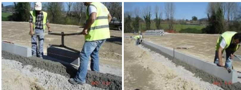
Figura 6.1-24 – Imagens relativas ao assentamento de lancis sobre lintel de betão
