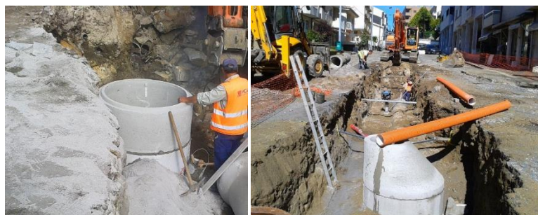
Figura 6.1-68 - Execução de caixas de visita em elementos pré-fabricados
