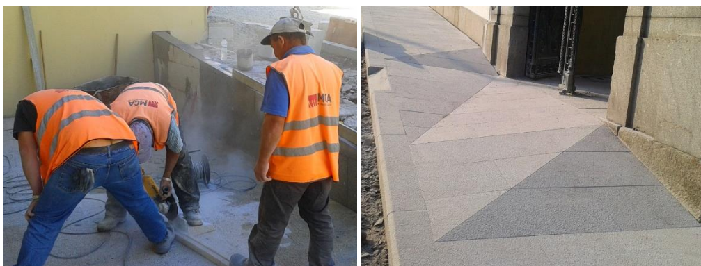
Figura 6.1-23 – Imagens relativas ao assentamento de lajeado de granito
