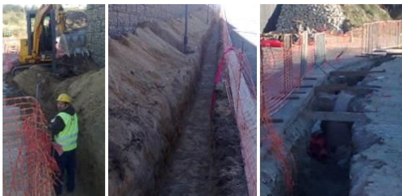
Figura 6.1-57 - Abertura de valas com altura reduzida para redes elétricas e de abastecimento
