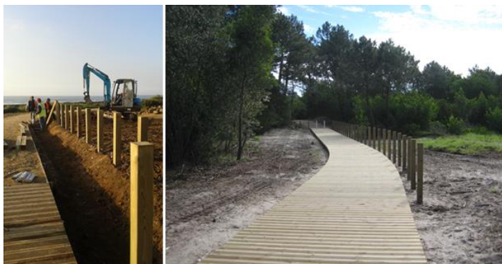
Figura 6.1-36 - Imagens relativas à aplicação de postes delimitadores em pinho tratado
