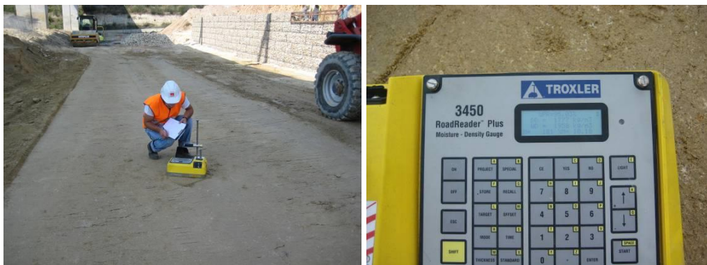
Figura 6.1-16 – Ensaio de compactação relativa “in situ” através do gama densímetro (Troxler)
