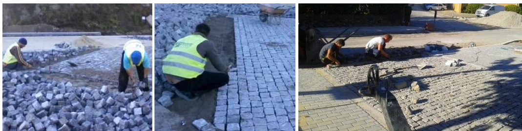
Figura 6.1-20 – Imagens relativas à aplicação de cubo de granito
