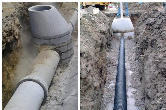
Figura 6.1-59 - Instalação de tubagens de dois tipos de redes (Betão – esq. e PP corrugado – dir.)
