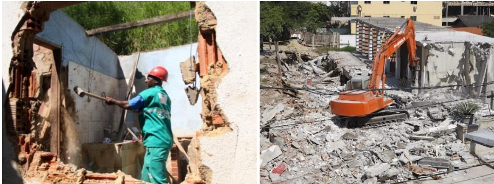
Figura 6.1-9 - Imagens relativas às diversas fases das demolições seletivas
