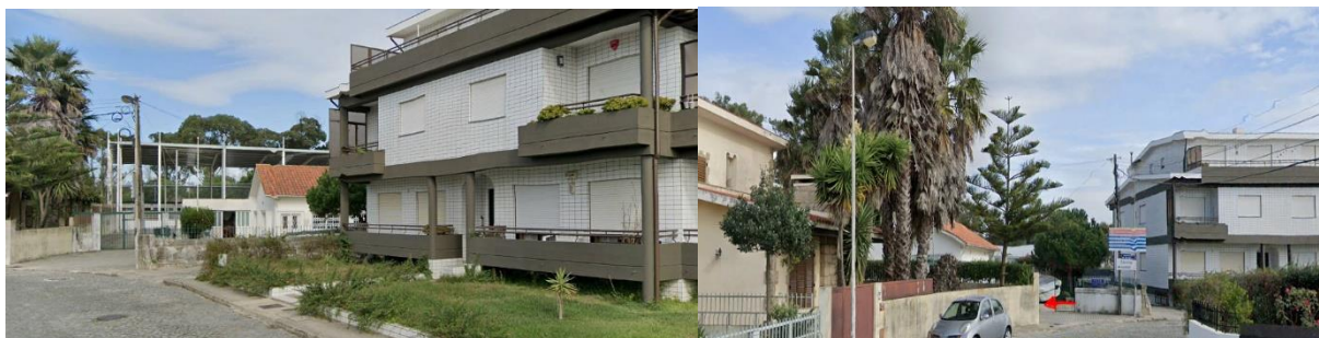
Figura 2.2: Condicionantes da empreitada – proximidade de zonas pedonais
