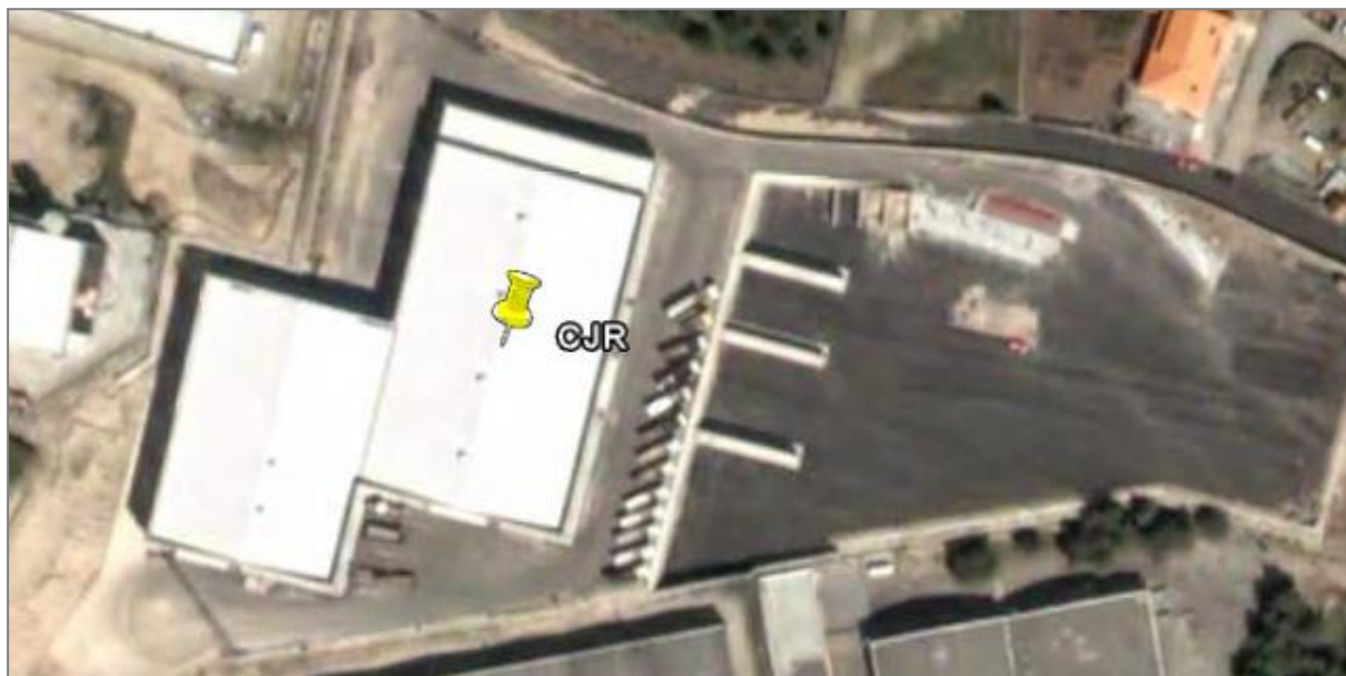
Figura 2.21: Vista aérea da sede e central de betuminosos da CJR
