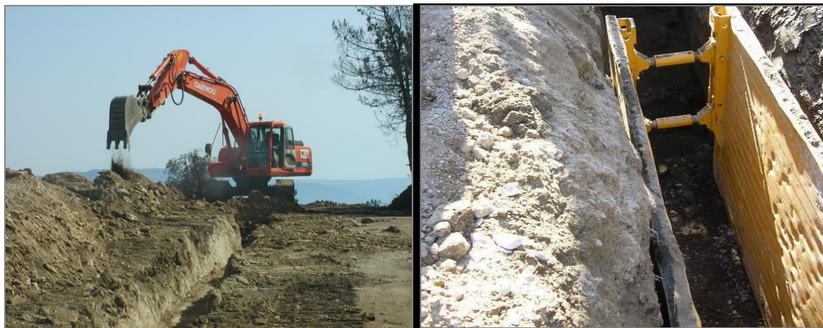
Figura 3.37: Escavação e entivação de Vala
