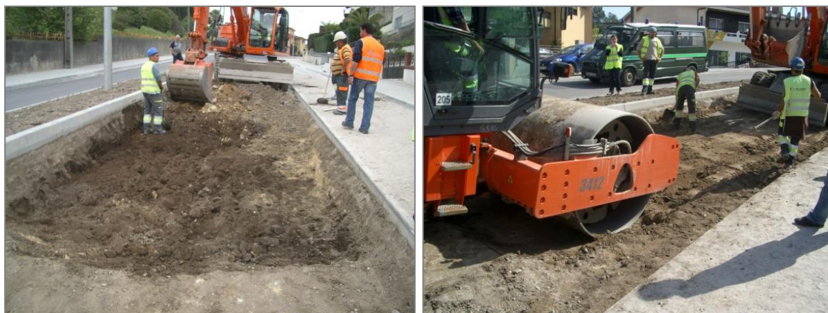
Figura 3.43: Abertura e regularização de fundo de caixa
