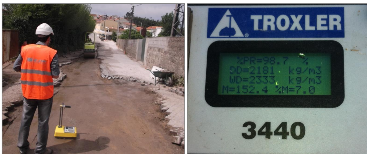
Figura 3.39: Ensaio de compactação das valas
