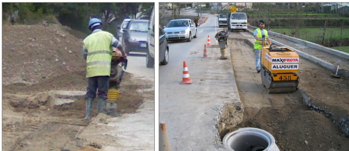
Figura 3.38: Almofada de assentamento na vala, fita sinalizadora e restante aterro e compactação da vala
