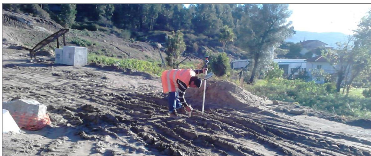
Figura 3.10: Marcação dos pontos com estacas de madeira e bandeirolas
