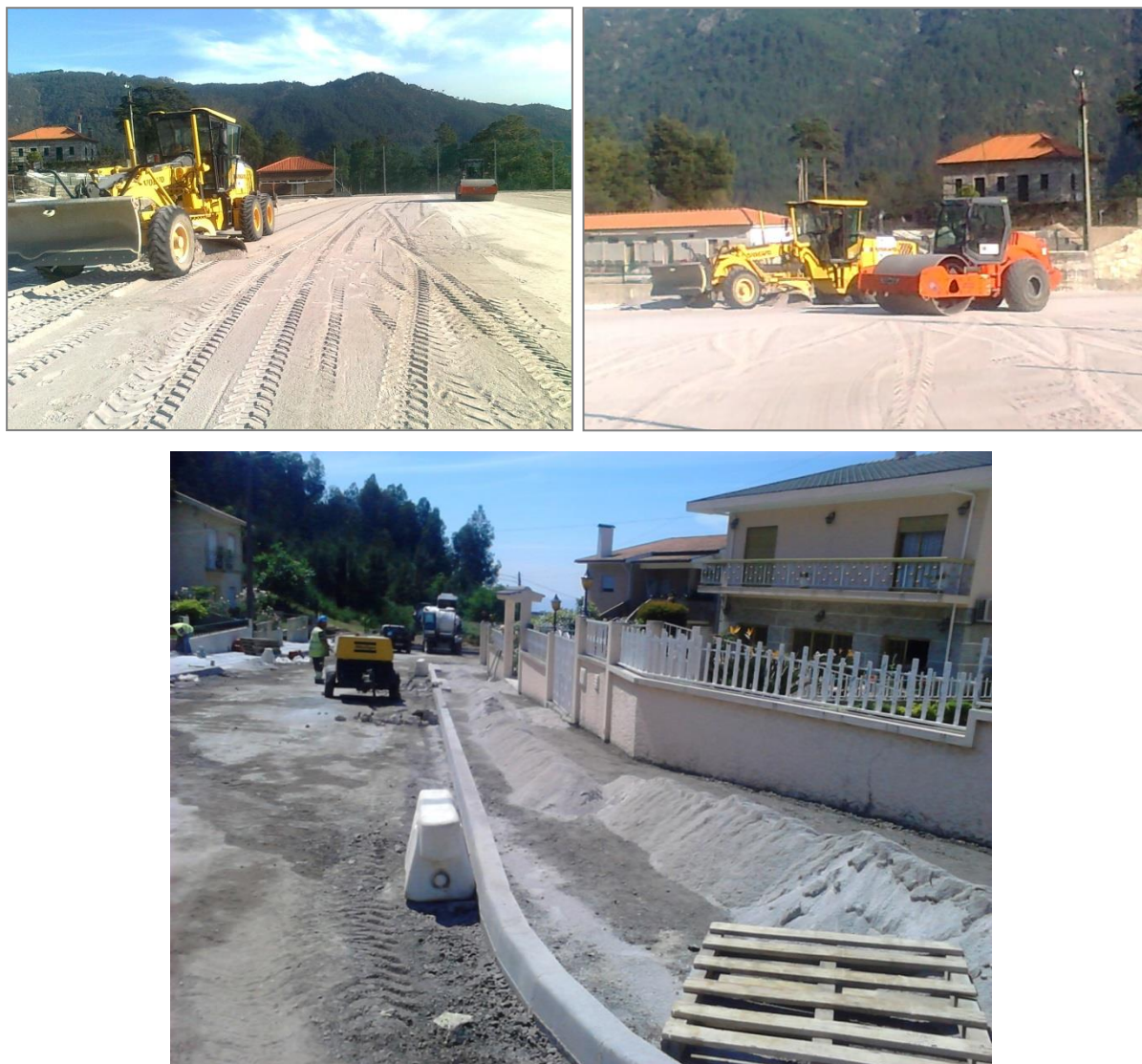
Figura 3.44: Espalhamento, regularização e compactação de Tout Venant
