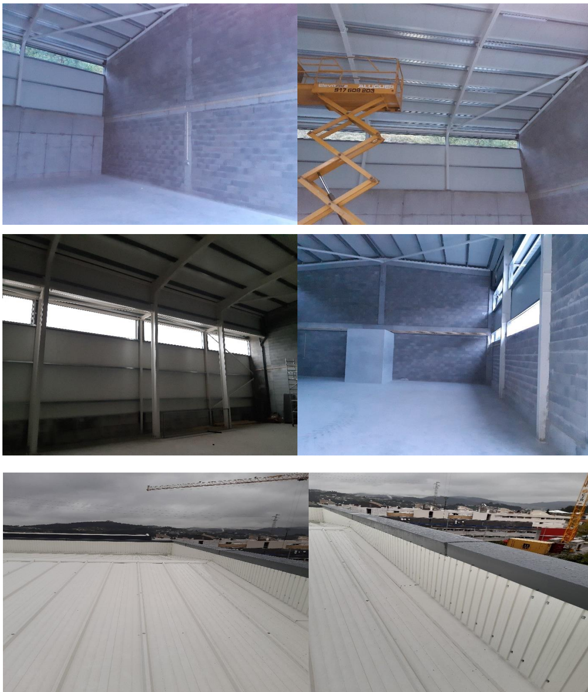
Figura 3.27: Exemplo de estrutura metálica
