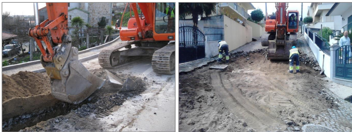
Figura 3.17: Levantamento de pavimentos
