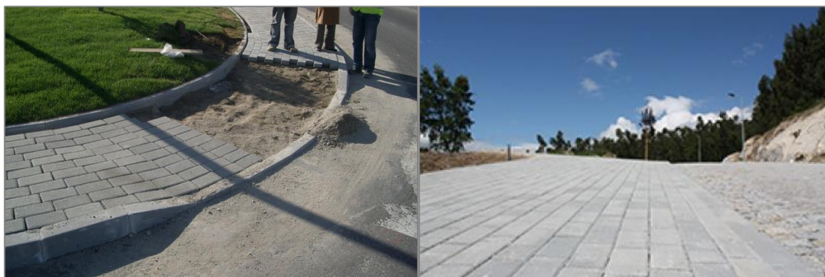
Figura 3.46: Assentamento de cubo e pedra do chão
