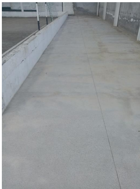
Figura 3.14: Pavimento de betão
