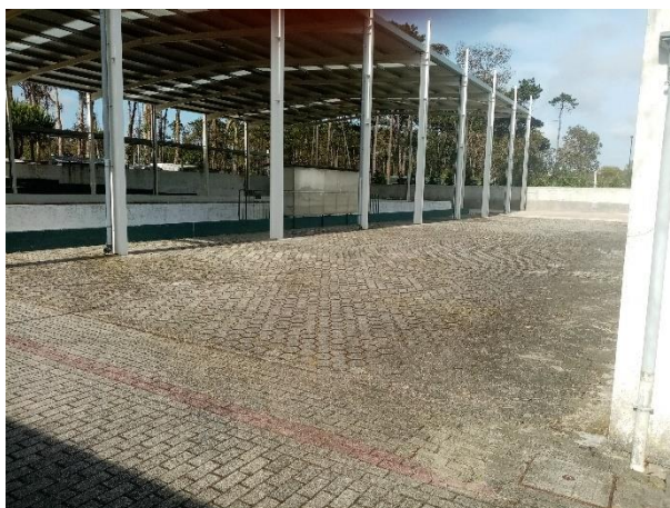
Figura 3.13: Pavimento em pré-fabricado de betão
