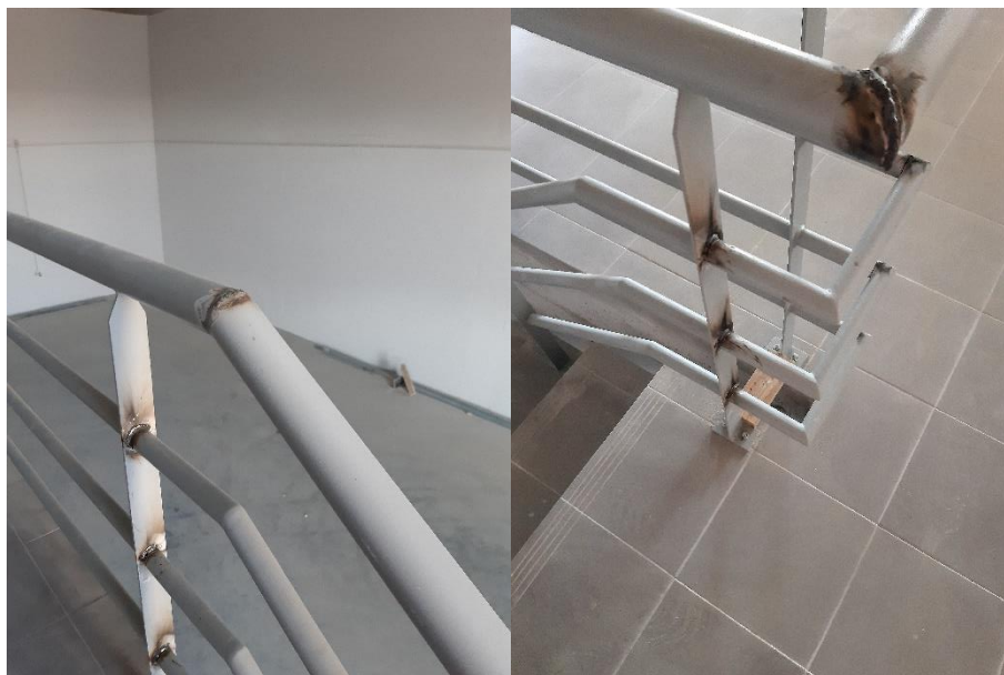
Figura 3.29: Pormenores de ligações de guarda-corpos
