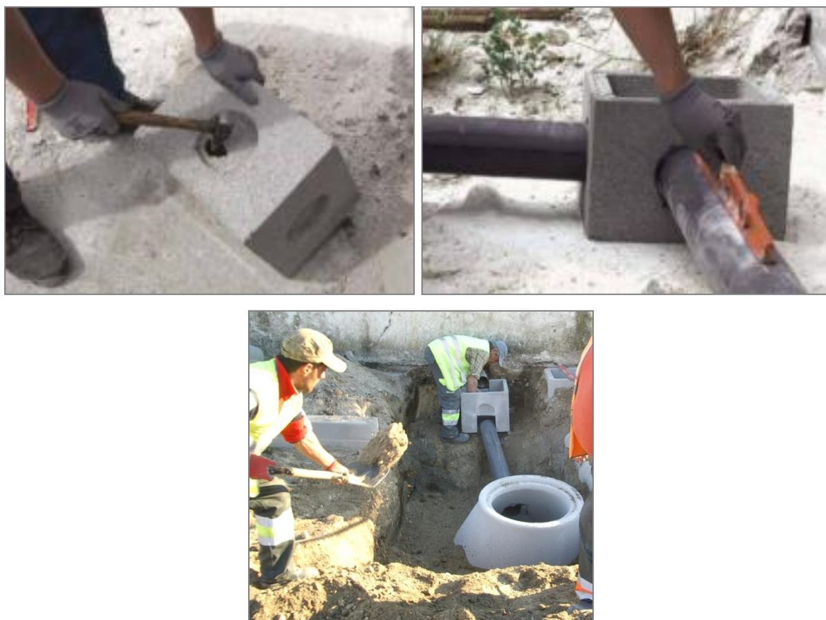
Figura 3.42: Execução de caixa de visita
