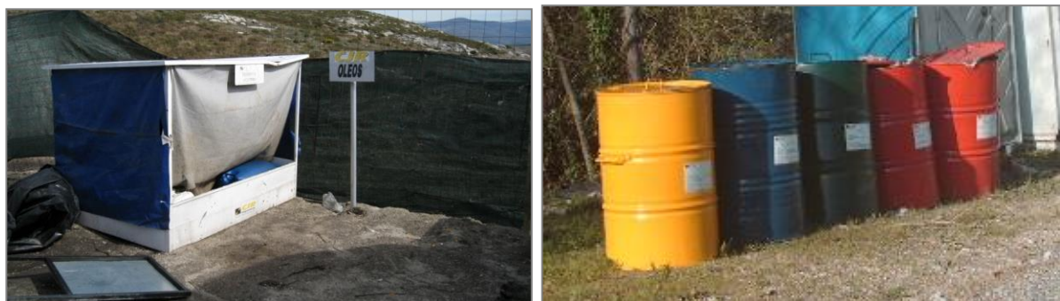
Figura 2.28: Zona de óleos e contentores de resíduos
