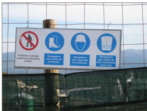
Figura 2.25: Placa segurança de entrada de estaleiro e vedação
