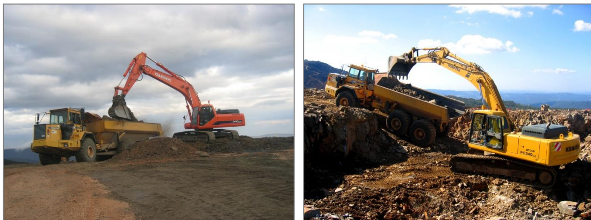
Figura 3.18: Escavação e transporte a vazadouro / depósito provisório
