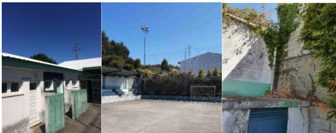
Figura 5: Possíveis pontos críticos (muro de suporte contiguo com o vizinho)
