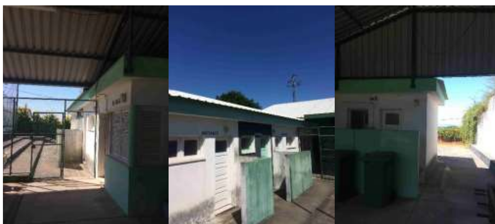
Figura 8: Estruturas de apoio
