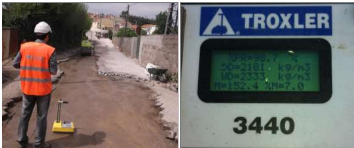
Figura 61: Ensaio de compactação das valas
