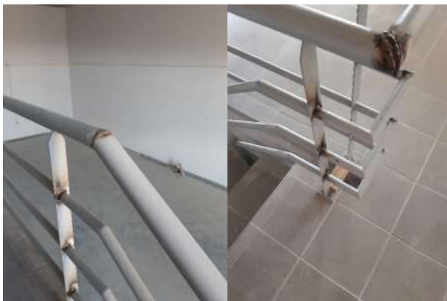
Figura 50: Pormenores de ligações de guarda-corpos
