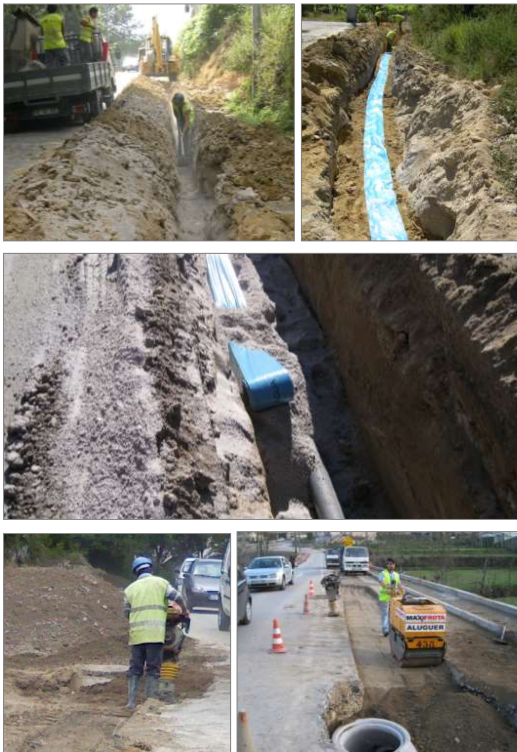
Figura 60: Almofada de assentamento na vala, fita sinalizadora e restante aterro e compactação da vala
