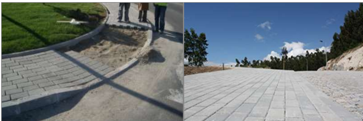
Figura 68: Assentamento de cubo e pedra do chão
