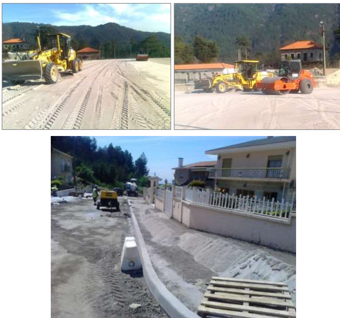
Figura 66: Espalhamento, regularização e compactação de Tout Venant
