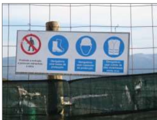
Figura 22: Placa segurança de entrada de estaleiro e vedação
