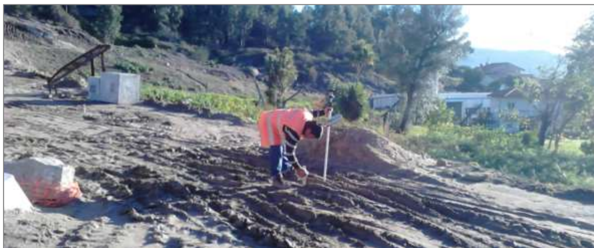
Figura 37: Marcação dos pontos com estacas de madeira e bandeirolas
