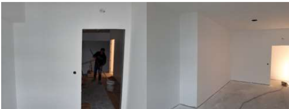
Figura 55: Execução de pinturas
