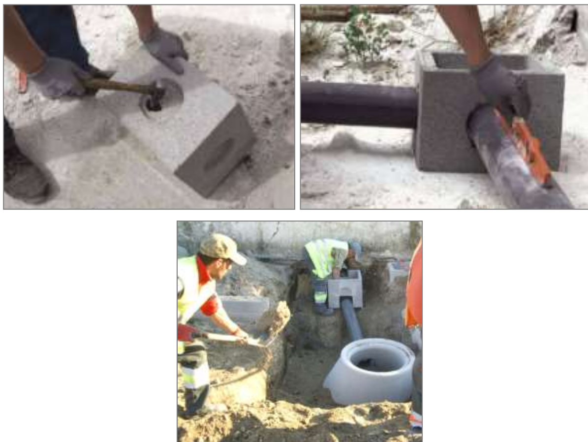
Figura 64: Execução de caixa de visita
