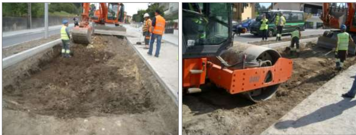
Figura 65: Abertura e regularização de fundo de caixa
