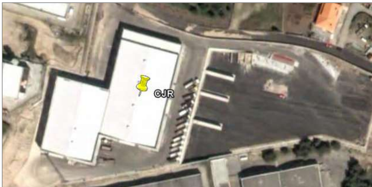
Figura 18: Vista aérea da sede e central de betuminosos da CJR
