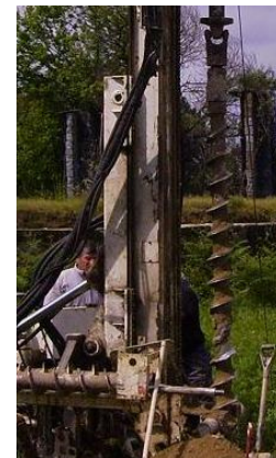
Figura 9 - Coluna de trados montada no equipamento
