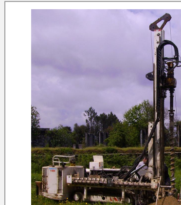
Figura 1 - Equipamento de perfuração FLOWTEX
