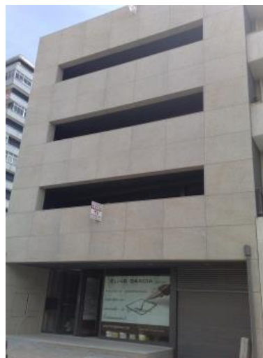
- Edifício Elias Garcias - Barcelos - 600.000€ - 2009
