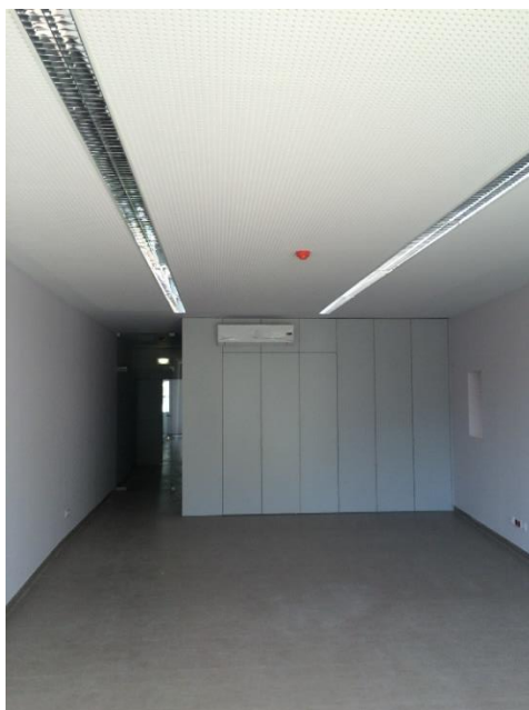
Exemplo de execução de teto falso em gesso cartonado (Edifício de Cultura e Turismo de Santa M. a Feira)
