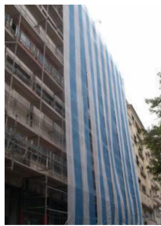
Exemplo de aplicação de andaime na fachada com rede de proteção
