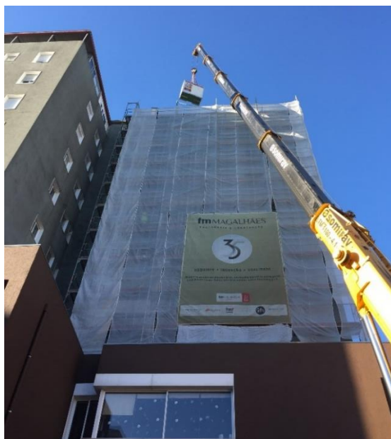
Exemplo de montagem de andaime em edifício com 10 pisos (Edifício Condes de Barcelos)
