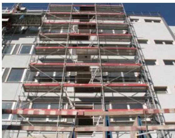
Exemplo de aplicação de andaime na fachada com rede de proteção
