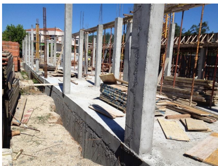
Execução de superestrutura em betão armado (Centro Educativo de Cervães)
