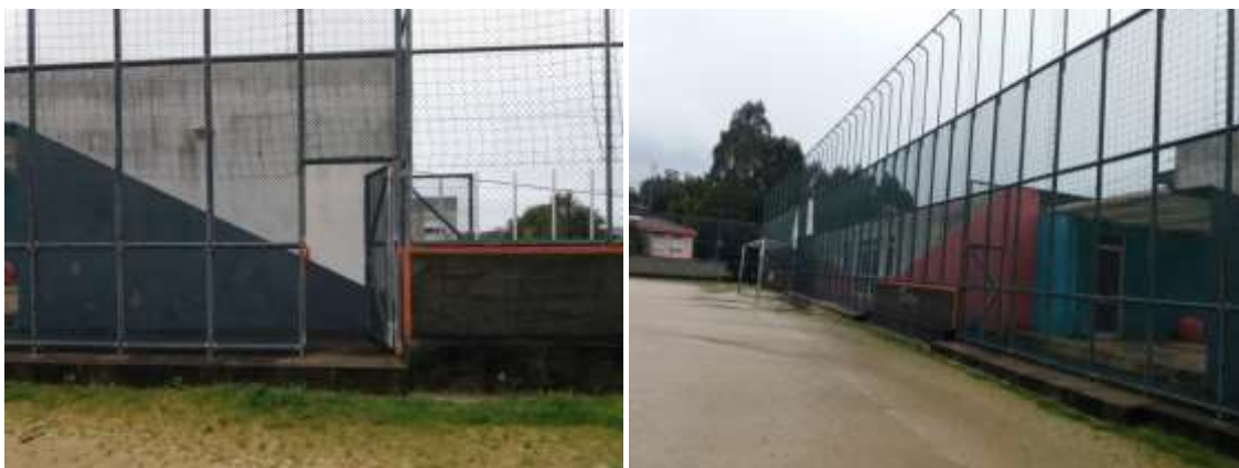
Figura 2.5 - Campo de Jogos de Fornelo – Vista atual da rede de drenagem existente
