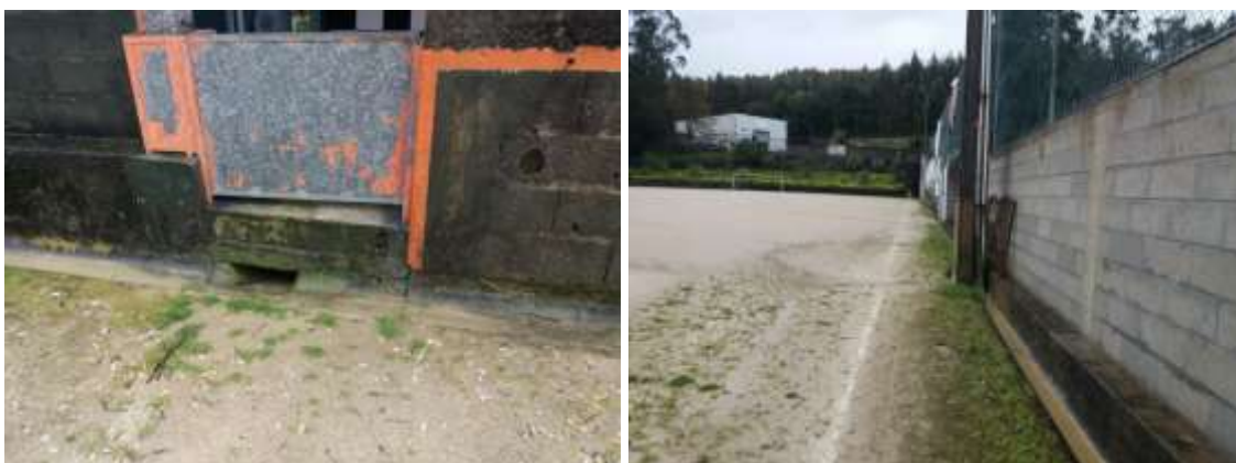
Figura 2.6 – Campo de Jogos de Fornelo – Vista atual da rede de drenagem existente
