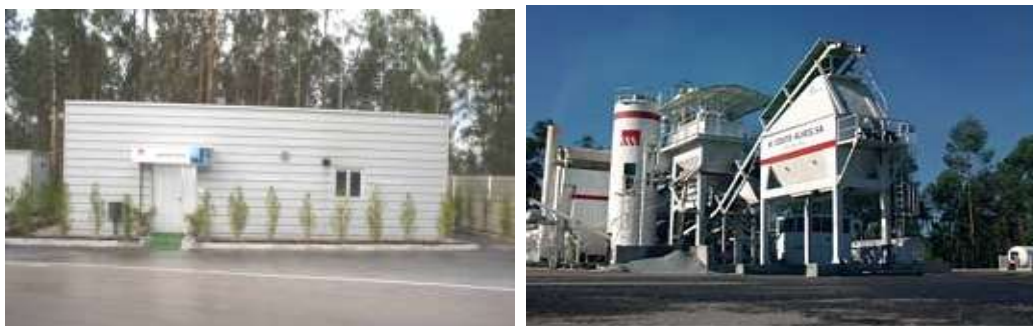
Figura 4.2 - Laboratório Central (à esquerda) e Central de Betuminosos (à direita)
