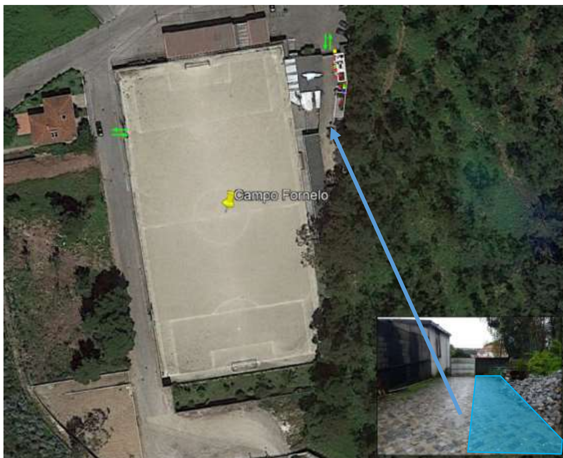
Figura 4.3 – Local de implantação do Estaleiro de Obra – Vista do Google Earth e vista atual
