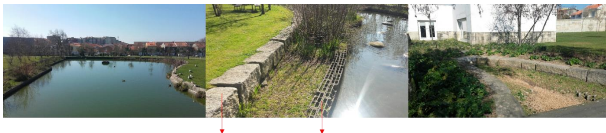
Fig.1 - Perímetro do lago em blocos de granito e lintel interior em blocos de cimento
