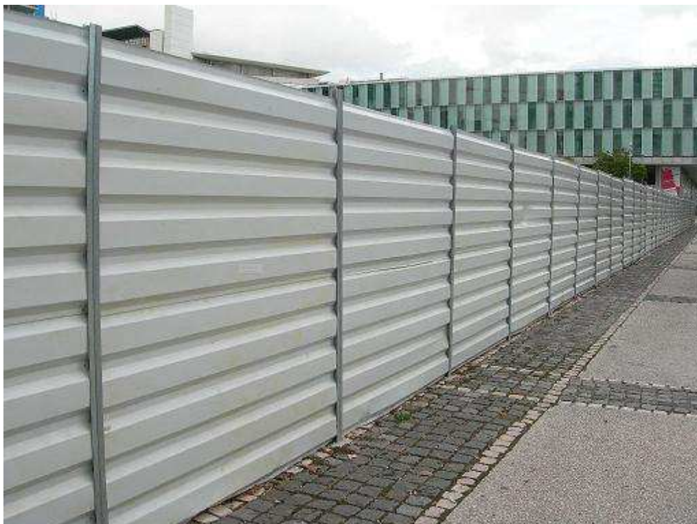
Figura 1 -- Vedação de estaleiro: a) em chapa metálica ondulada; b) barreira amovível.
