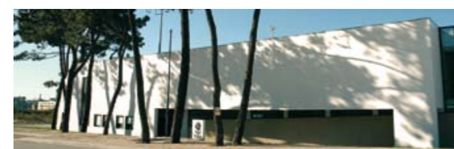
Efectivos da GNR em Vila do Conde serão reforçados com 68 novos elementos
