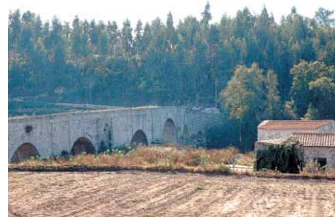
Finalmente vai avançar a recuperação da Ponte D. Zameiro
