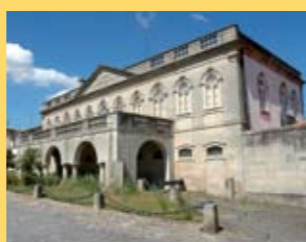
O conjunto de edifícios onde está instalado o Museu Agrícola constitui o assento da Casa de Lavoura do Rio Ave
