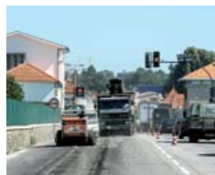
Intervenção na EN13 visa repor as condições de tráfego, conforme exigência da Câmara Municipal
