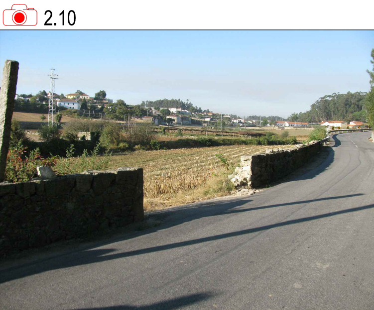
MURO ALVENARIA. ENTRADA EXISTENTE.
