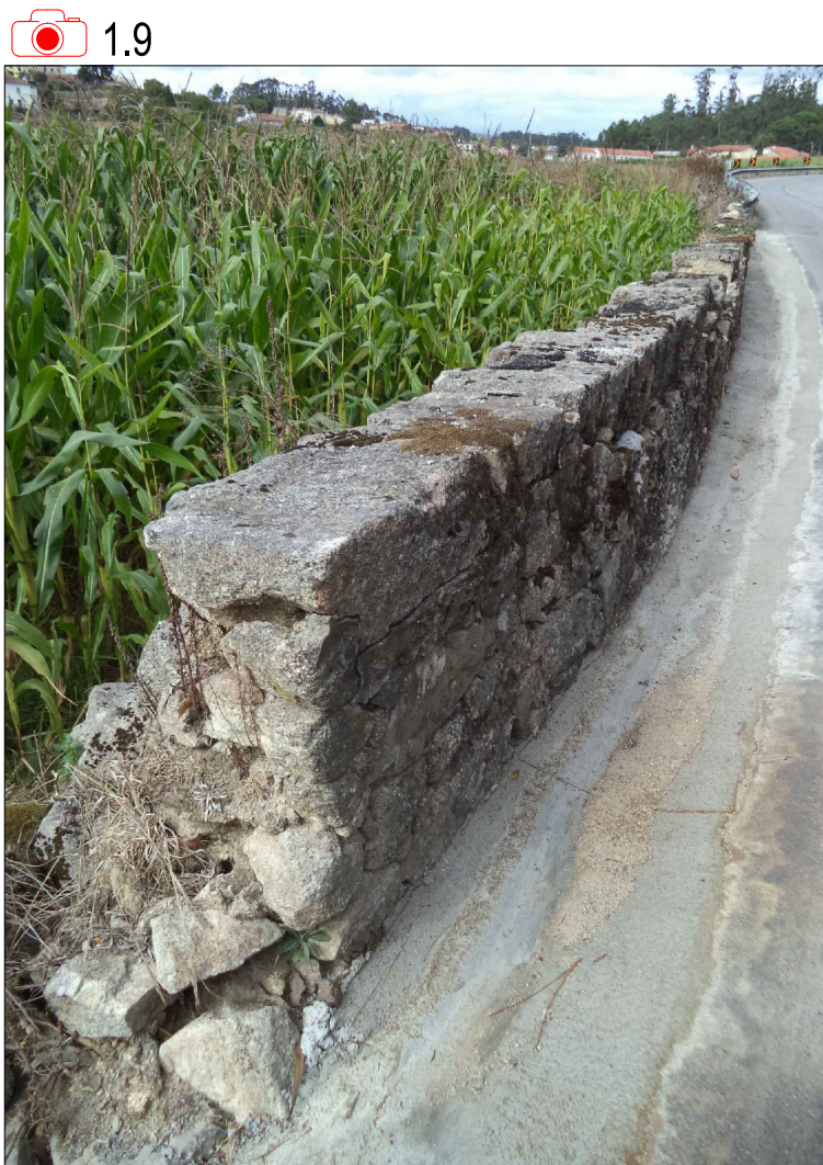
MURO ALVENARIA. DRENAGEM SUPERFICIAL.
