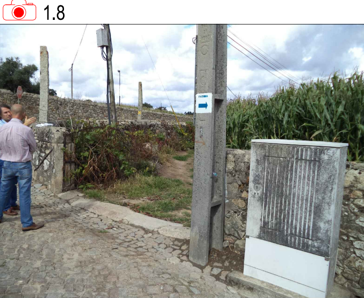
ARMÁRIO ELÉTRICO. POSTE ILUMINAÇÃO.
