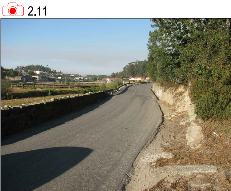
EN 306 - VISTA PARA NORTE.
