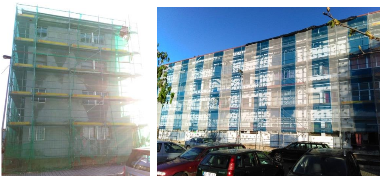
Figura 21 - Exemplo de andaime em obra (Obra Bairro de S. Roque da Lameira - Porto)
