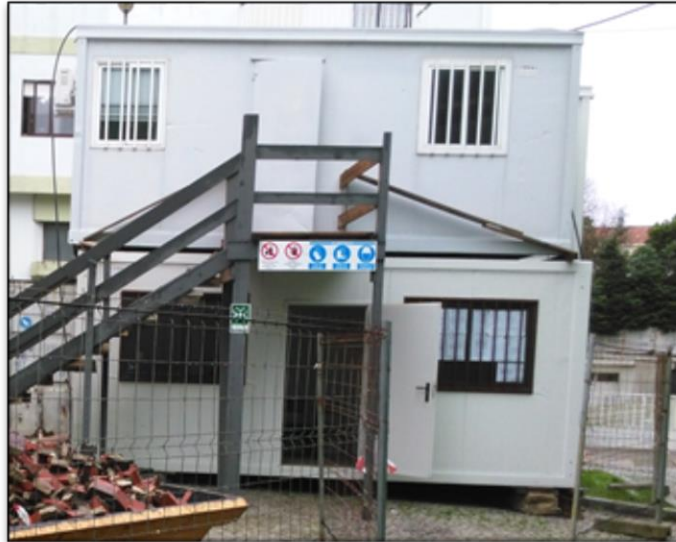
Figura 12 - Módulos para escritório / sala de reuniões (Obra Bairro de S. Roque da Lameira - Porto)
