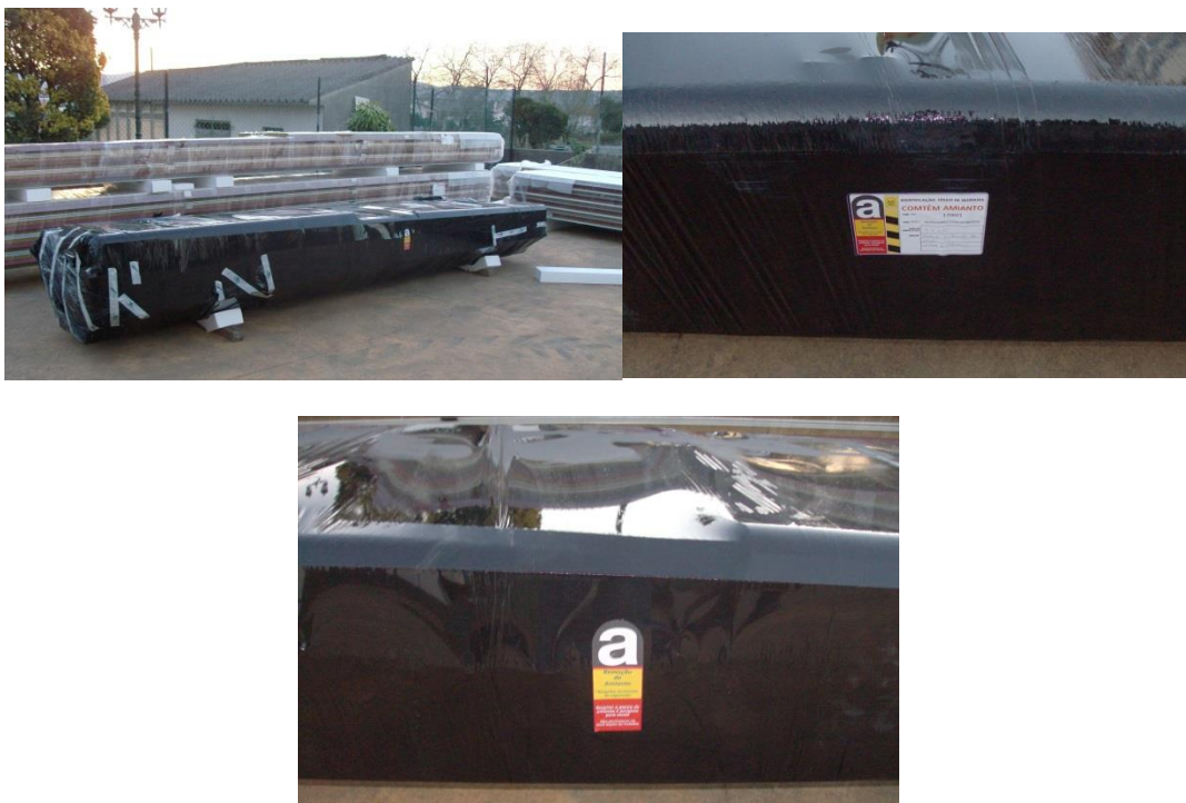
Acondicionamento de material em paletes devidamente seladas e identificadas
