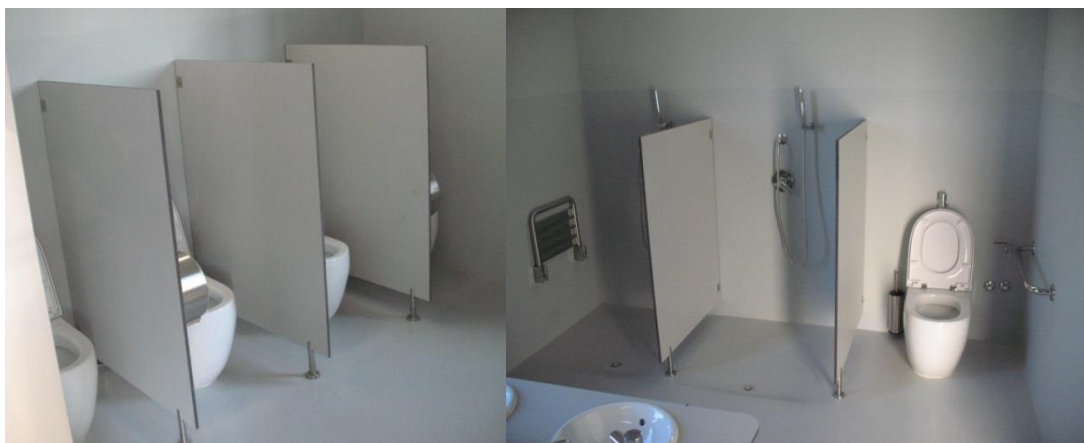
Exemplo de aplicação de divisórias (Obra Jardim de Infância Angeiras)
