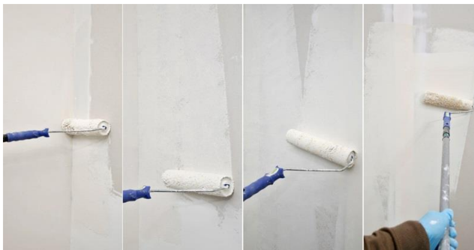
Figura 27 - Exemplo de aplicação de pintura (Rolo)
