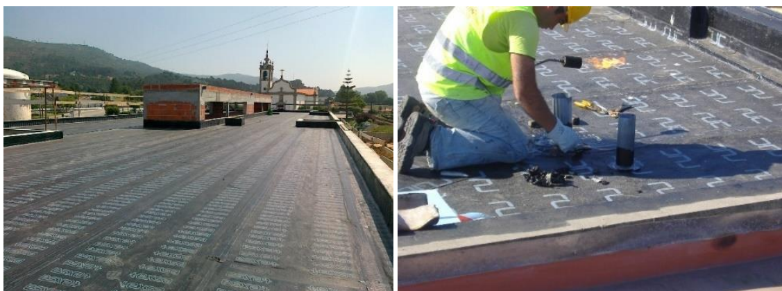
Figura 28 - Exemplo de aplicação de telas de impermeabilização
