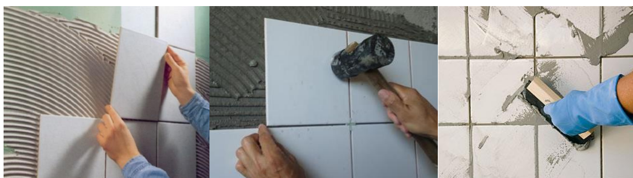
Figura 26 - Exemplo de aplicação de cerâmicos
