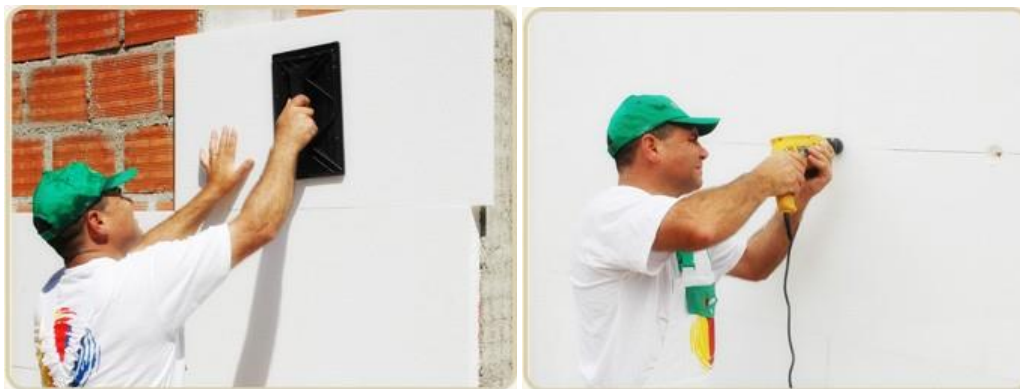
Figura 29 - Exemplo de aplicação do sistema capotto
