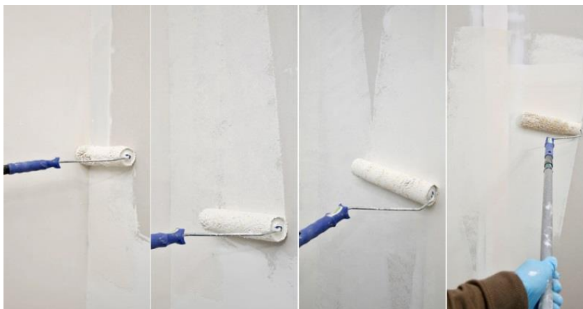
Exemplo de aplicação de pintura (Rolo)
