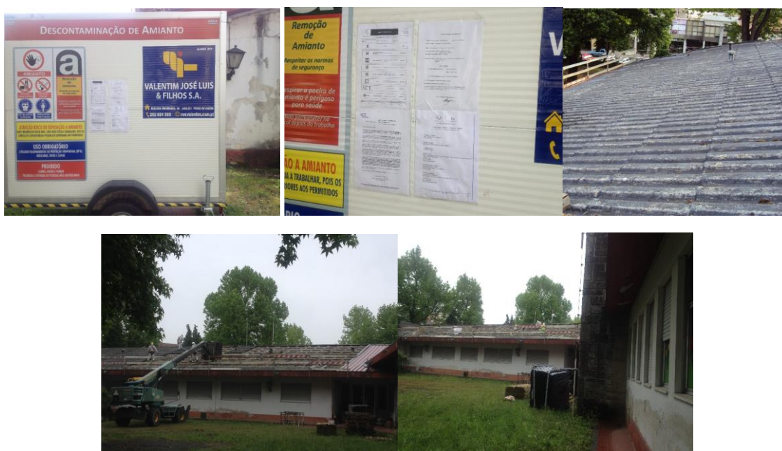
FIGURA 1 – FOTOGRAFIAS DE EMPREITADAS QUE ENVOLVERAM A REMOÇÃO DE AMIANTO
