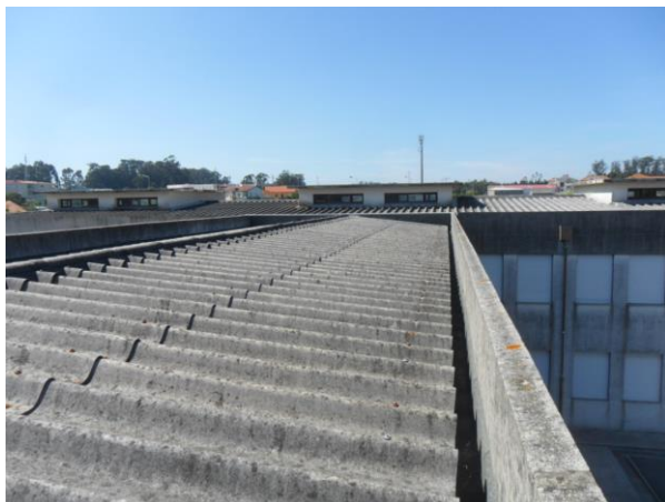
Foto – cobertura em fibrocimento
