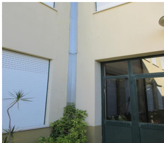
Foto – junta de dilatação
