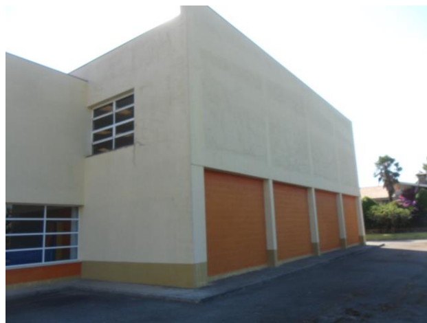
Foto – Fachada do pavilhão
