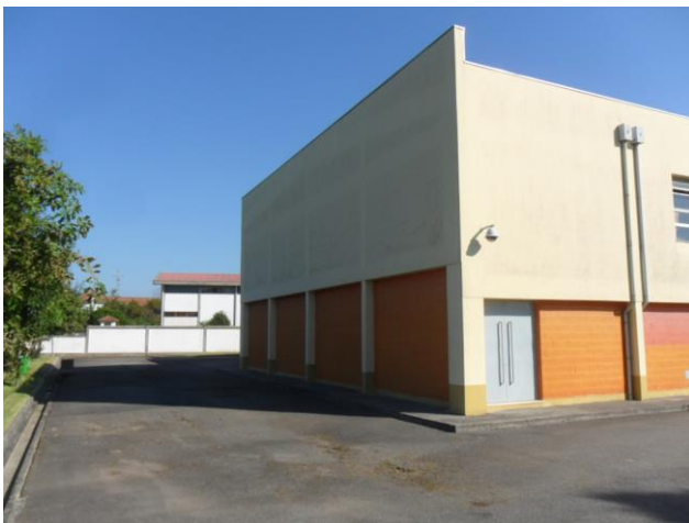
Foto – Fachada do pavilhão
