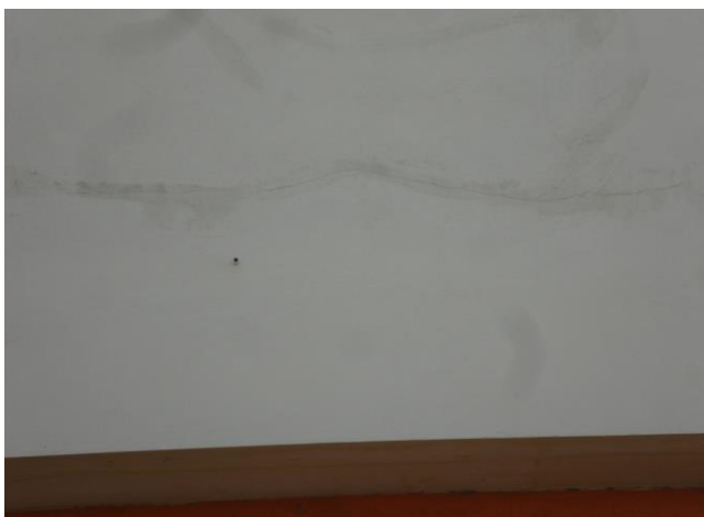
Foto – Fachada do pavilhão
