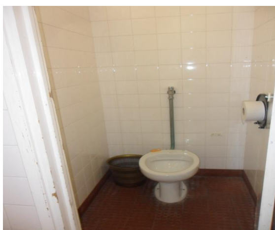
Foto 22 – Zona da sanita
