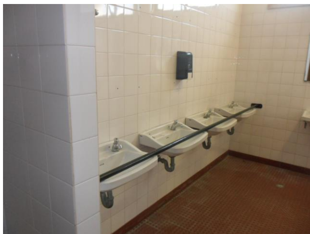
Foto 19 – Zona de lavatórios
