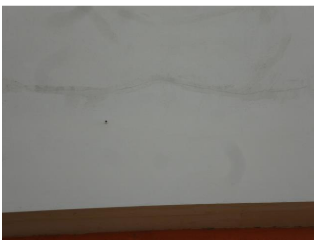
Foto 28 – Fachada do pavilhão
