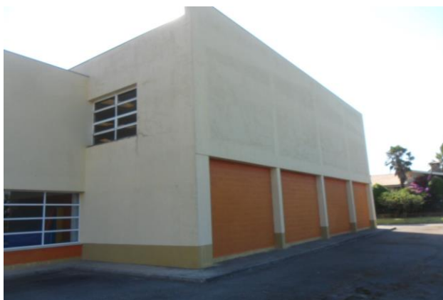
Foto 31 – Fachada do pavilhão
