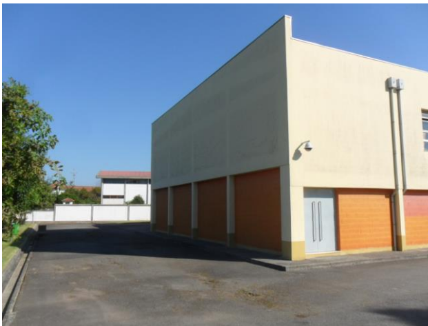
Foto 30 – Fachada do pavilhão
