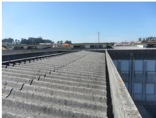
Foto 1 – cobertura em fibrocimento
