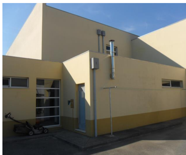
Foto 34 – Fachada do pavilhão
