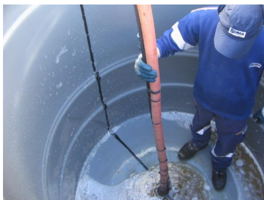
Figura 5-2 – Aspiração das Águas Sujas
