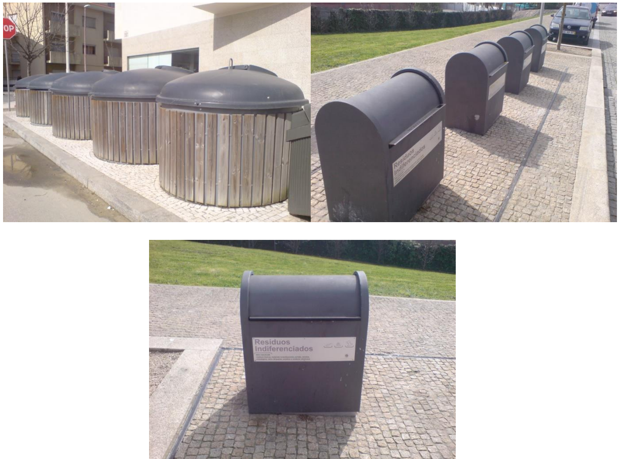
Figura 3-11 – Contentores enterrados e semi-enterrados
