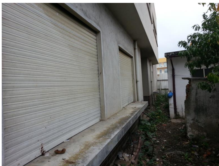
Ilustração 26 – Construções a demolir para construção das novas infra-estruturas
