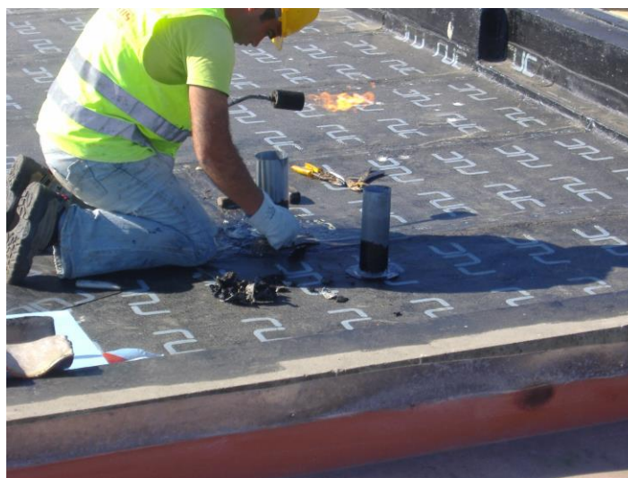
Ilustração 33 - Exemplo de aplicação de telas
