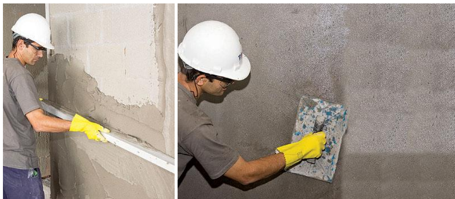
Ilustração 34 - Exemplo de execução de reboco
