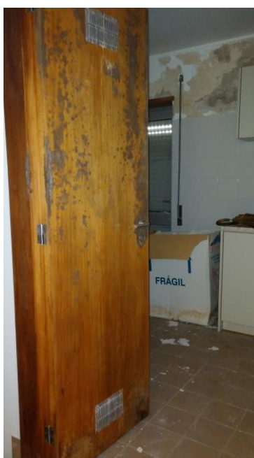
Ilustração 42 - Portas da cozinha existentes
