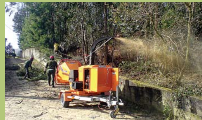
Operação de corte de ramificações excessivas
