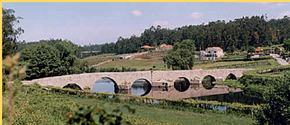
Ponte de D. Zameiro
