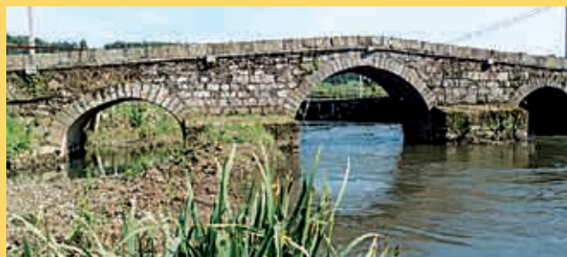
Ponte românica de Arcos
