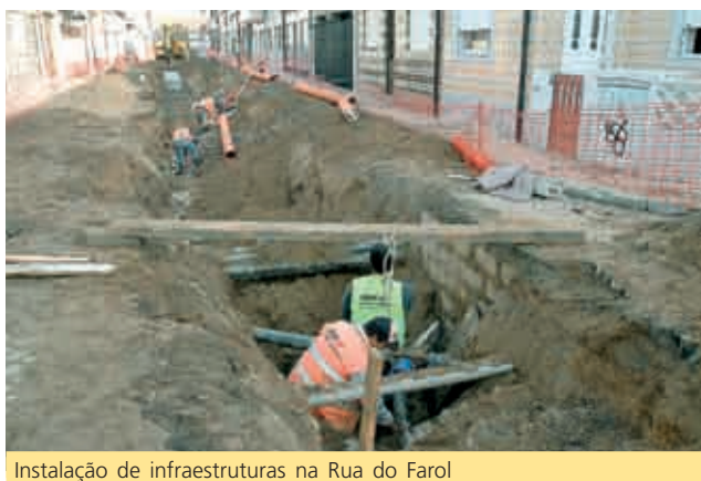
Instalação de infraestruturas na Rua do Farol
