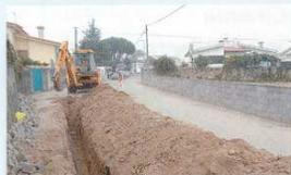
Construção de estações elevatórias junto à Urbanização do Recife e nas Calçadas que viabilizarão a recolha e lançamento no emissário dos esgotos domésticos das redes entretanto construídas.
